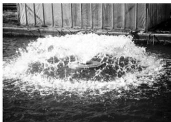
Figura 6. Aireador de turbina vertical
