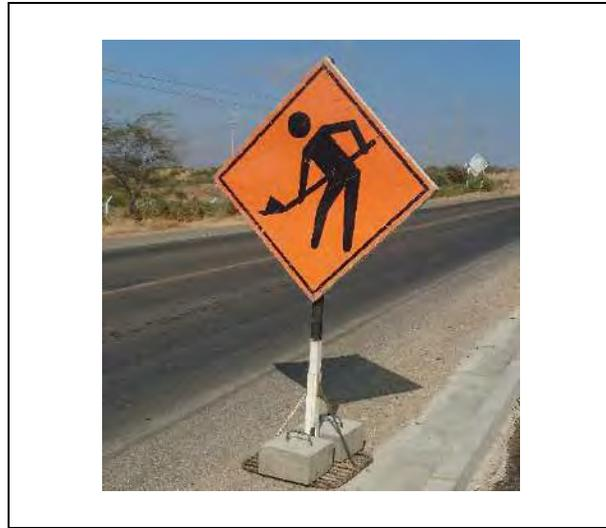
Figura 2. Ejemplo de soporte portátil par señalización
