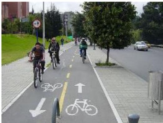
Figura 3. Ciclovía segregada bidireccional.
