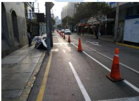
Figura 4. Ciclovía parcialmente segregada bidireccional.
