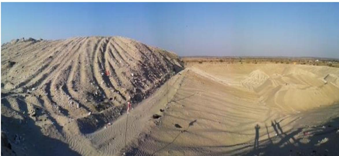
Figura 12 Celda habilitada para la disposición de residuos sólidos en el botadero.
