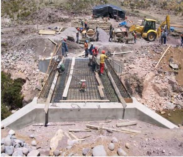
Foto 4.25 - Encofrado y armado de la losa.
