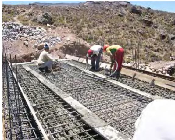
Foto 4.28 - Vaceado y vibrado de la losa.
