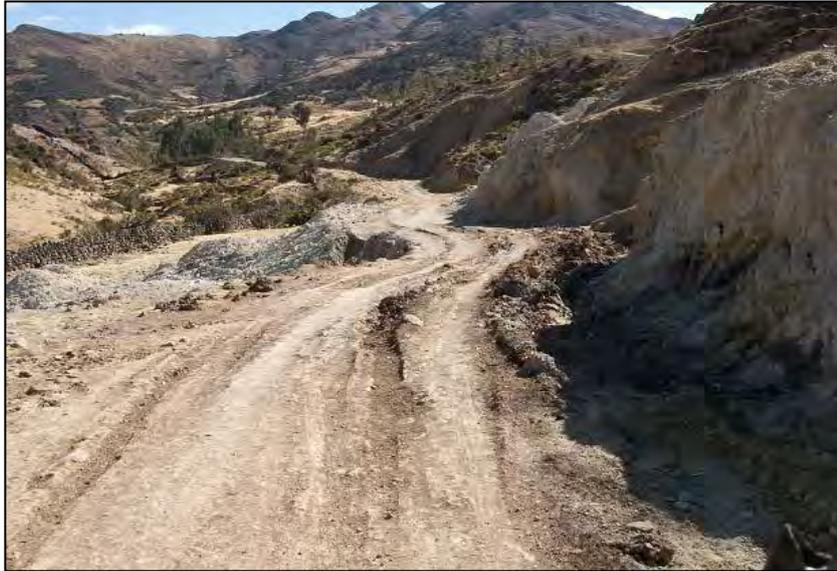
**Foto N° 3.2 – Kilómetro 08 + 200: La plataforma deformada por falta de cunetas**
