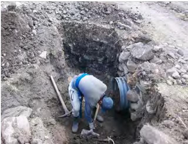
**Foto 4.11 - Excavación de zanja para cabezales**
