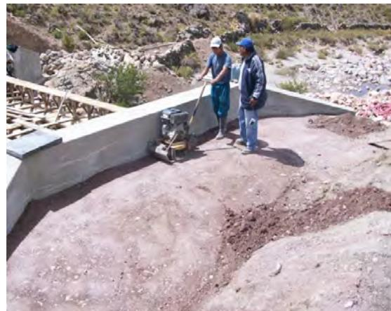
Foto 4.30 - Relleno y compactado entre el estribo y el talud.
