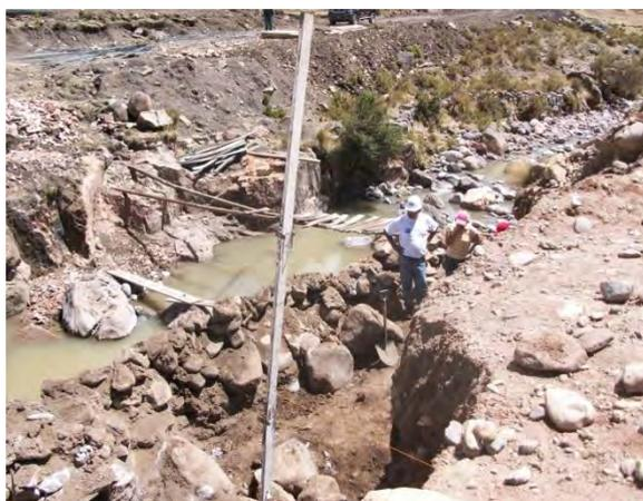
**Foto 4.21 - Excavación para el estribo izquierdo.**
