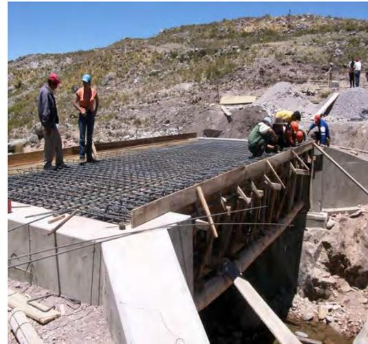
Foto 4.26 - Armado de losa concluido
