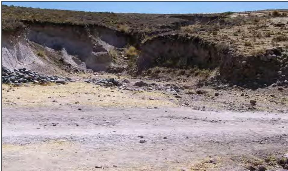
**Foto N° 3.3 - Kilómetro 14 + 530: Plataforma con material arcilloso**
