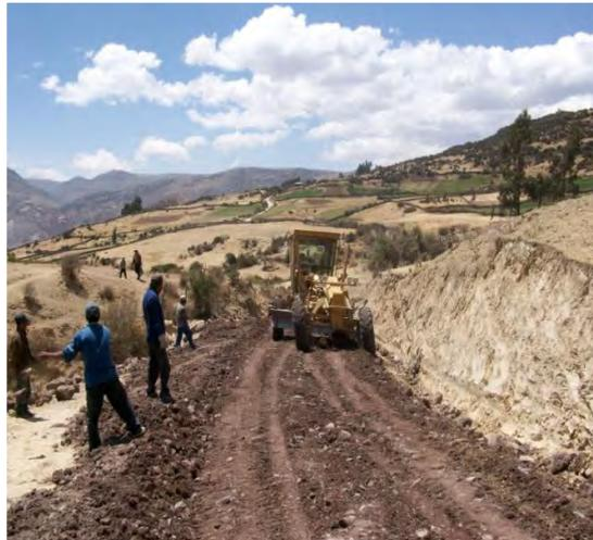
**Foto 4.8 – Extendido riego y compactado de material de afirmado.**
