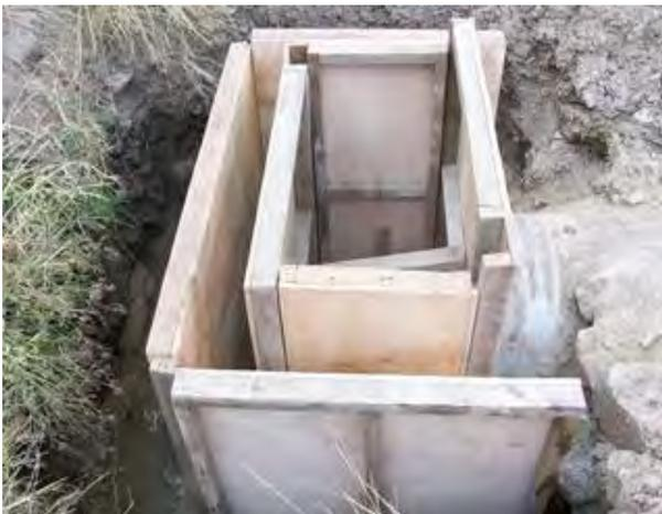
**Foto 4.13 – Encofrado para cabezales.**
