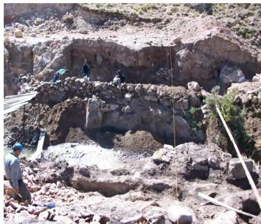
**Foto 4.22 - Excavación el estribo derecho**
