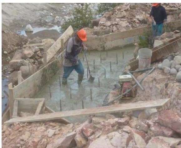
**Foto 4.23 - Encofrado y vaciado de los estribos.**
