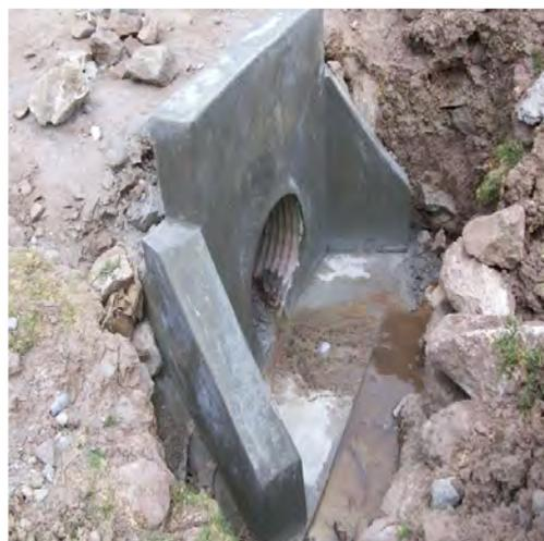
**Foto 4.16 Cabezal de salida**
