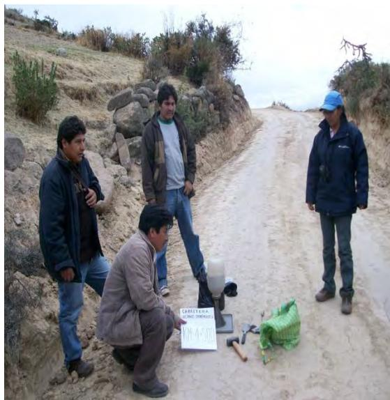
**Foto 4.3 - Compactado de la subrasante. Foto 4.4 - Prueba de densidad de campo.**
