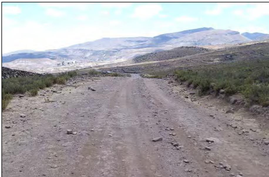
**Foto N° 3.4 – Kilómetro 19 + 470: Plataforma con presencia de material grueso.**
