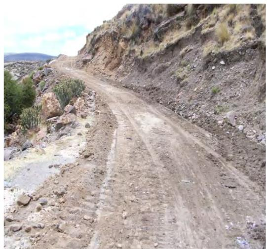
**Foto 4.1. Perfilado de la plataforma con tractor. Foto 4.2 Ampliación de la vía.**
