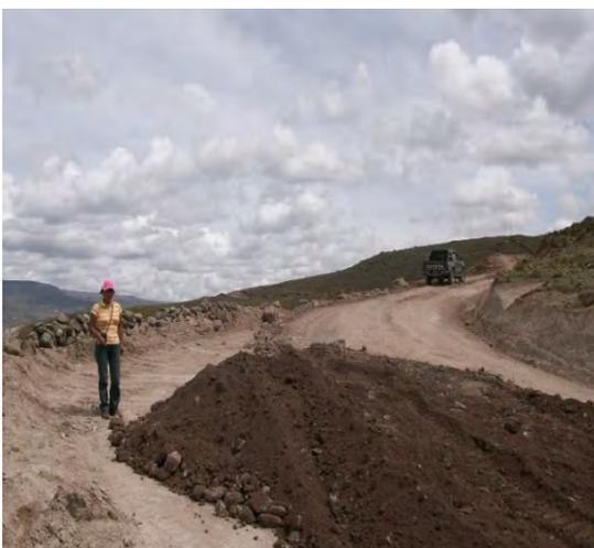
**Foto 4.7 – Extendido de material en la plazoleta de cruce.**
