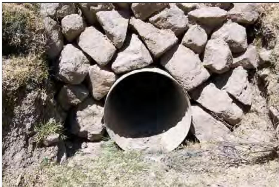
**Foto N° 3.5 - Kilómetro 2 + 450: Alcantarilla con muro de piedra**
