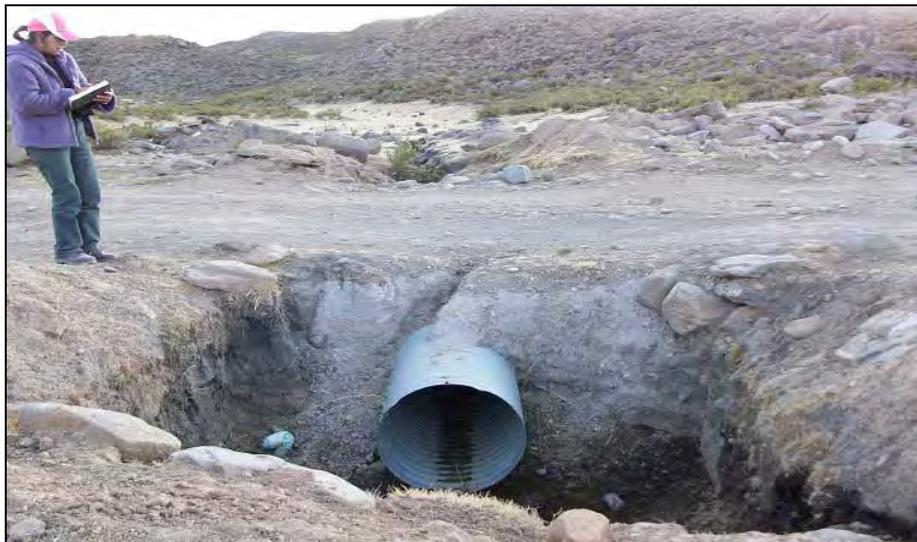
**Foto N° 3.8 km. 20 + 890: Alcantarilla con el TMC expuesto**
