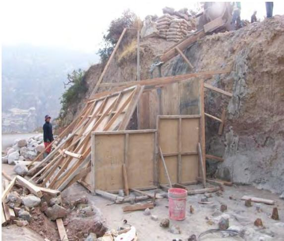
**Foto 4.19 - Encofrado y vaceado del muro**
