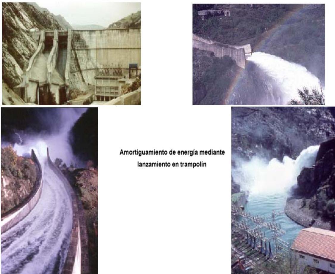
Amortiguamiento de energía mediante
