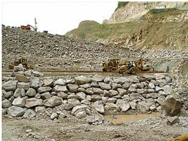
**Figura 2.8** Enrocado al volteo en una presa de tierra.
