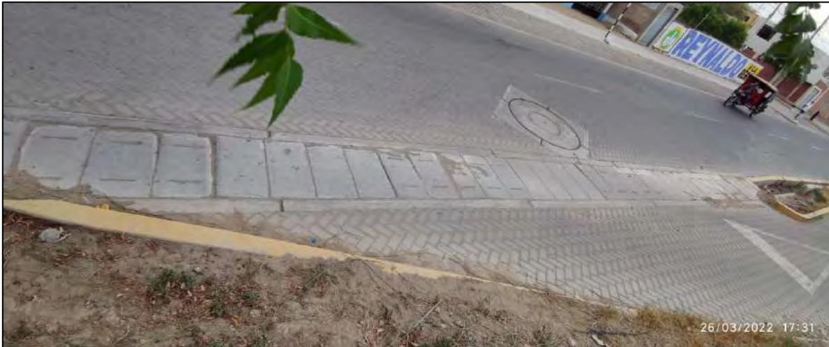
Figura 105. Tapas de concreto para facilitar acceso a los ciclistas
