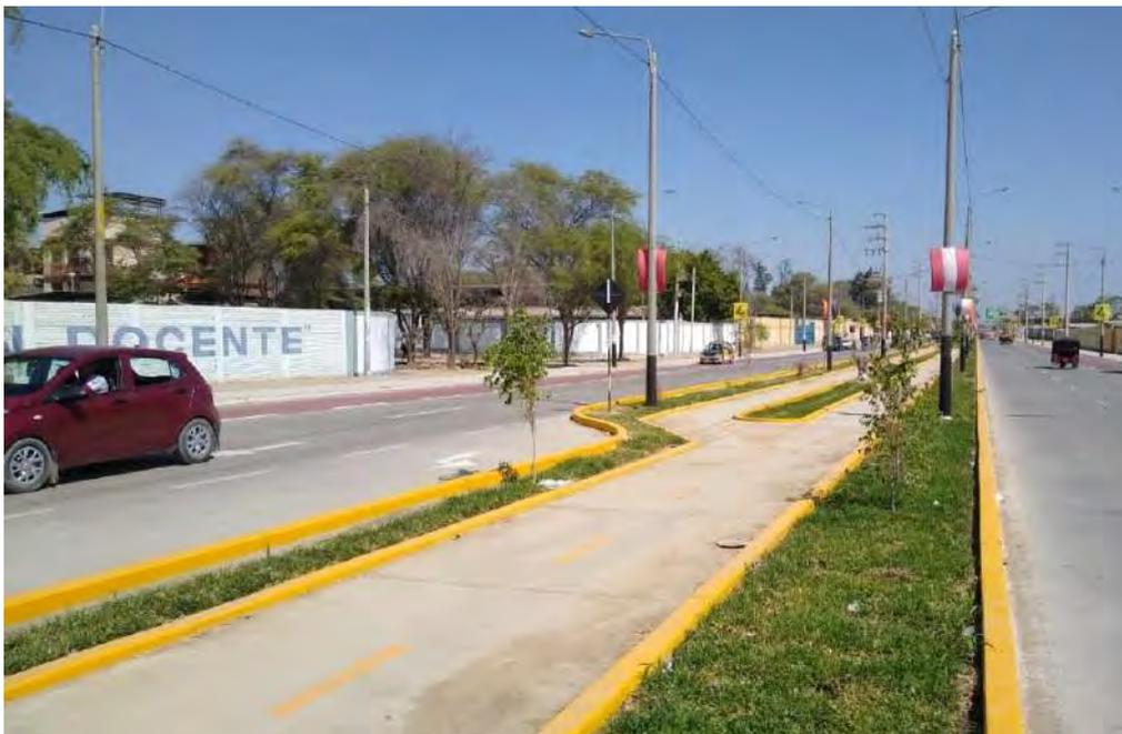
Figura 10. Ciclovía de la Avenida Chulucanas, donde se puede apreciar un separador central entre los carriles
