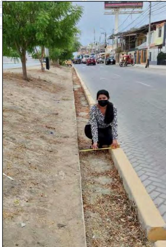
Figura 104. Medición en campo del ancho de las cunetas
