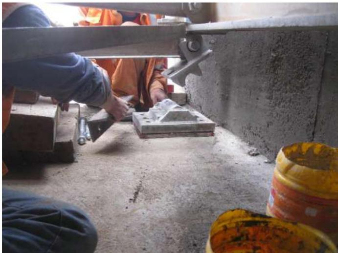
Figura 60. Detalle de instalación de apoyo móvil
