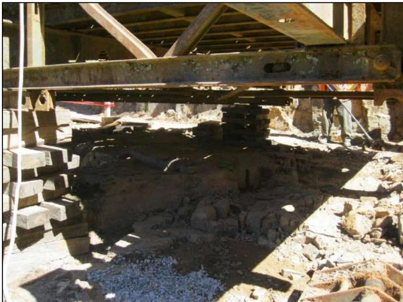
Figura 38. Colocación de tacos de madera
