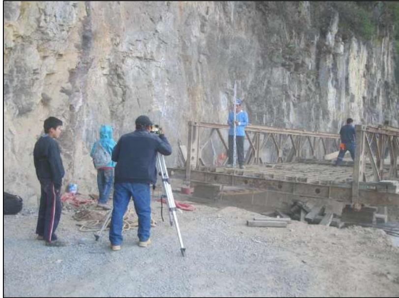
Figura 33. Servicio de trazo, nivelación y replanteo
