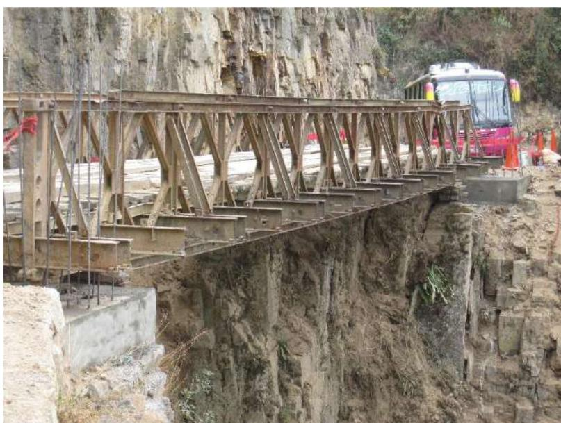
Figura 48. Concreto en zapatas: Dados de concreto estribo derecho e izquierdo
