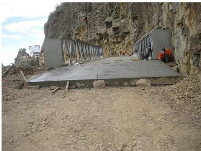
Figura 58. Losa de aproximación lado derecho
