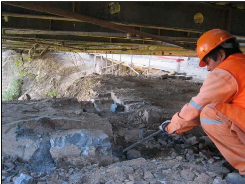
Figura 45. Excavación en material roca
