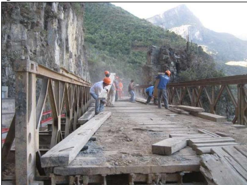
Figura 39. Desmontaje de Maderamen
