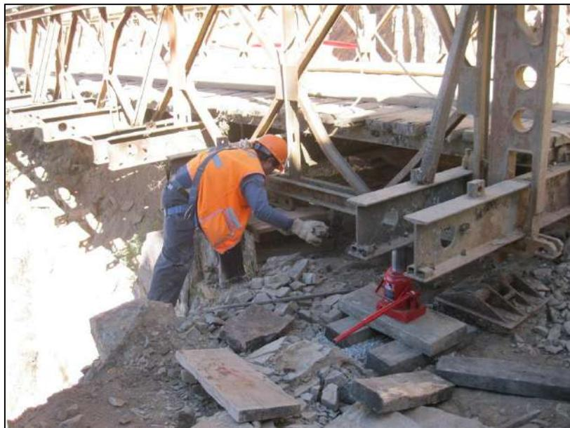
Figura 37. Gateo y colocación de tacos de madera
