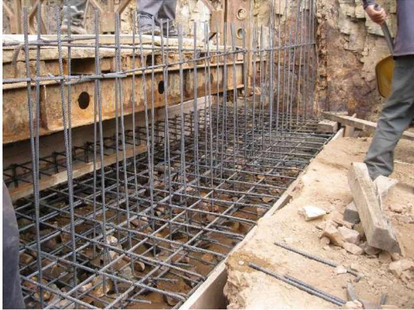
Figura 49. Encofrado estribo derecho
