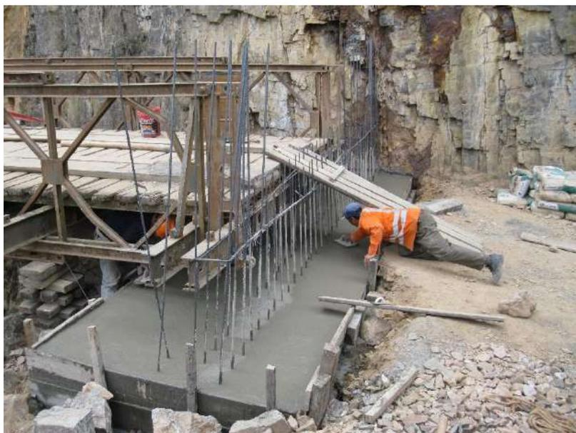
Figura 47. Concreto en zapatas: Dados de concreto estribo derecho
