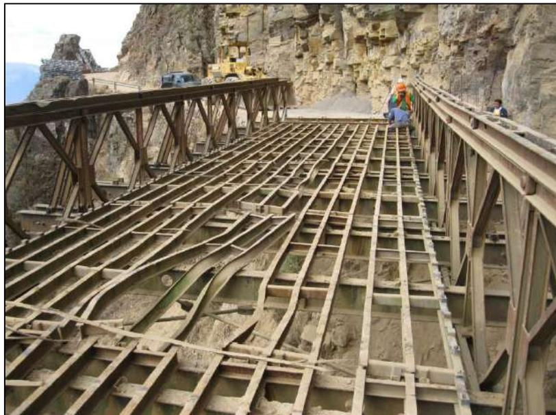
Figura 3. Emparrillados del tablero del Puente Bailey Contumazá dañados.
