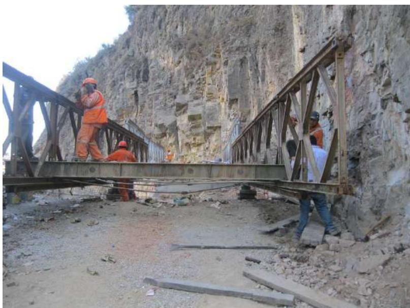
Figura 73. Desmontaje de estructura Bailey
