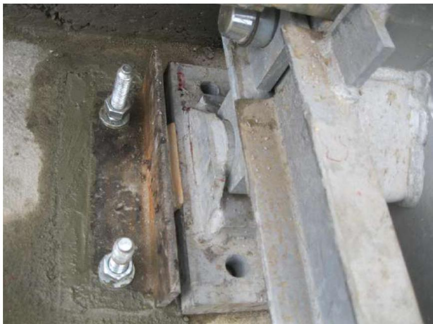
Figura 61. Detalle de instalación de apoyo móvil
