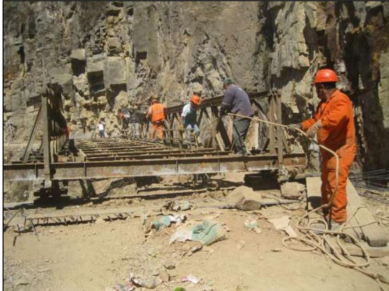
Figura 55. Desmontaje de emparrillados de tablero puente Bailey
