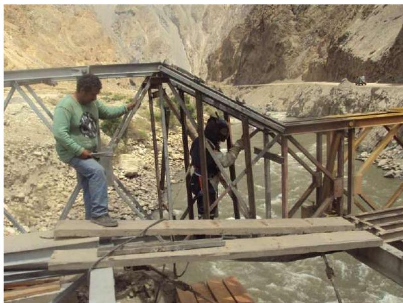
Figura 70. Trabajos de soldadura en acople Puesto Bailey – Puerto Acrow
