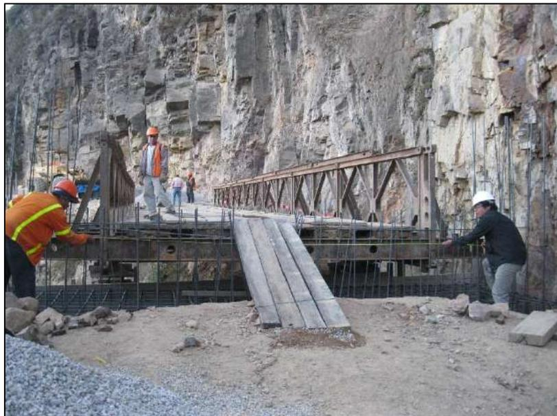
Figura 53. Habilitación de acero para parapetos y muros contraimpacto
