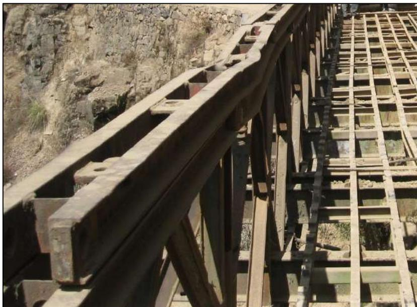
Figura 4. Cordones de refuerzo del Puente Bailey Contumazá dañados.
