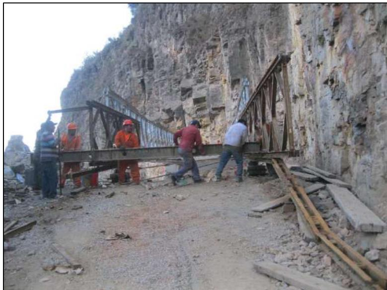
Figura 56. Desmontaje de emparrillados de tablero puente Bailey
