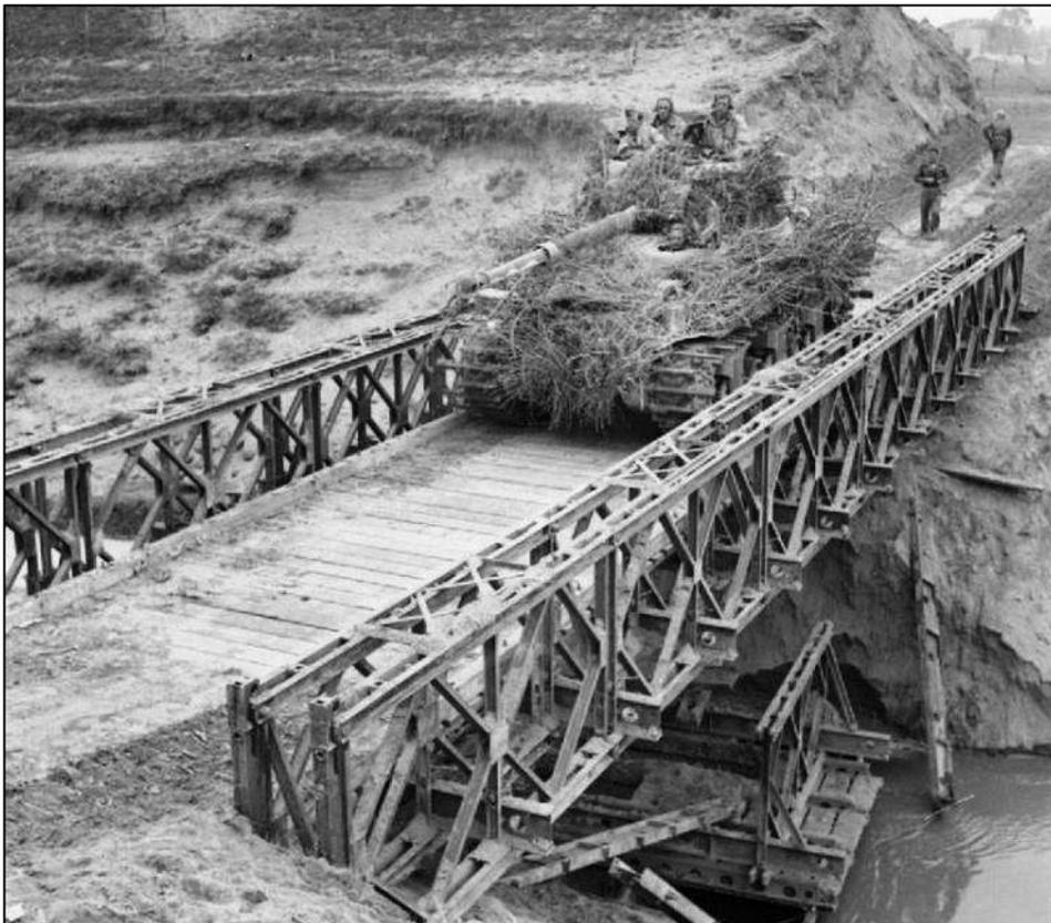
Figura 15. Un tanque de Sherman fuertemente camuflado cruza un puente de Bailey sobre el río Santerno cerca de Imola, el 12 de abril de 1945
