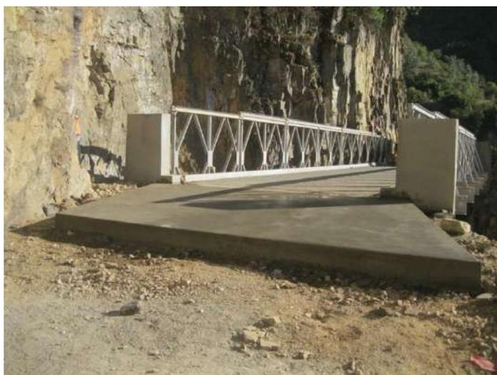
Figura 57. Losa de aproximación lado izquierdo
