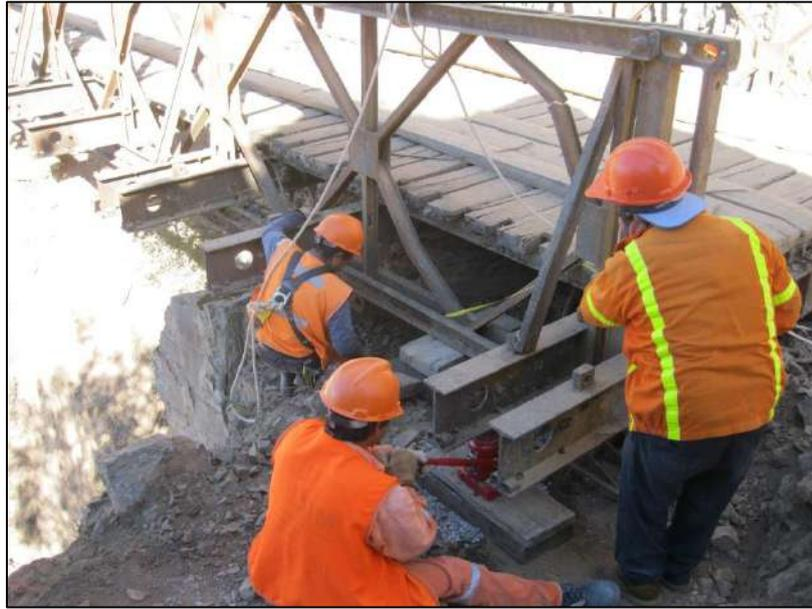
Figura 36. Servicio de Gateo de estructuras para construcción de apoyos
