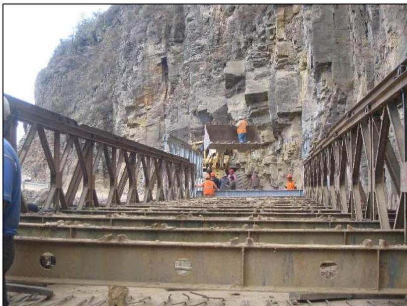
Figura 54. Lanzamiento puente modular Contumazá
