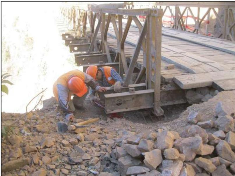
Figura 11. Apoyo puente Bailey Contumazá km 99+881
