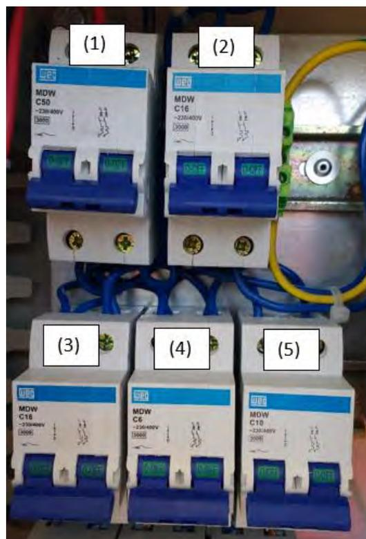
Figura 2.28. Llaves termo-magnéticas dentro del tablero de energía principal.
