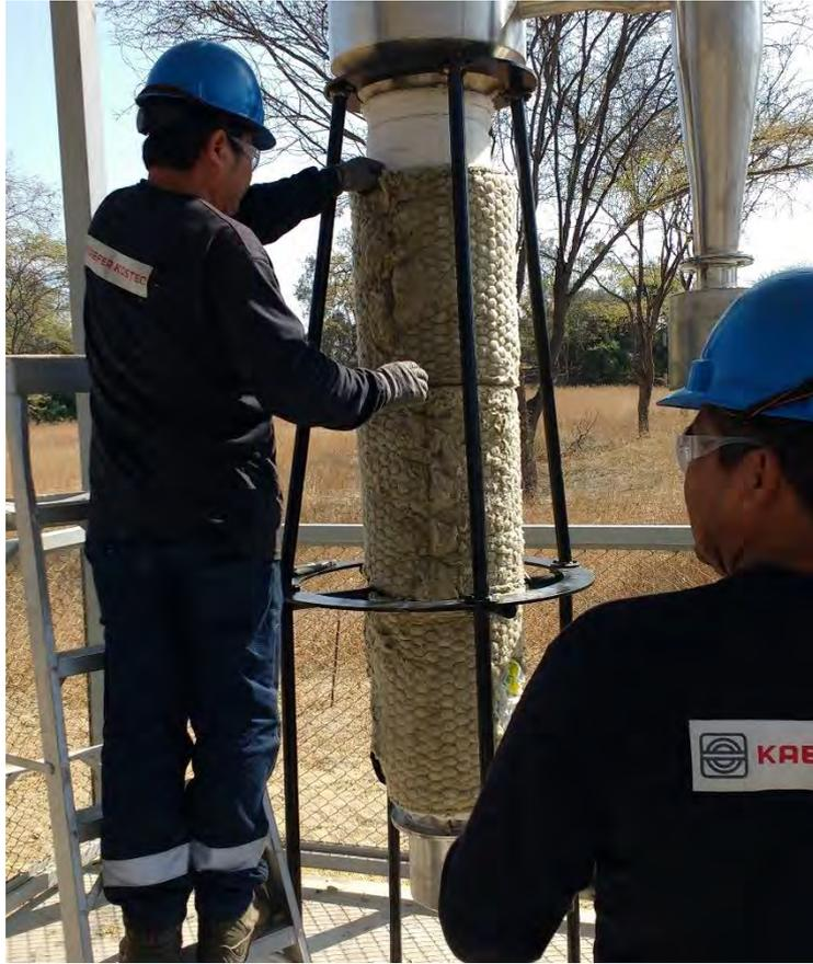
Figura 2.24. Segunda capa del recubrimiento térmico.
