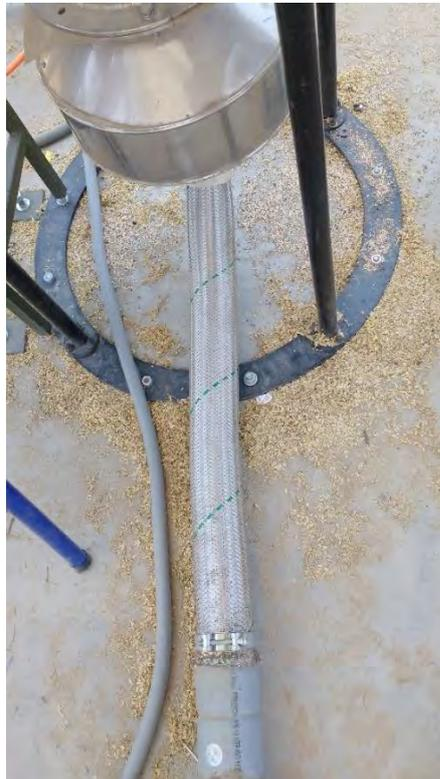
Figura 2.46. Conexión del subsistema soplador con el gasificador.
