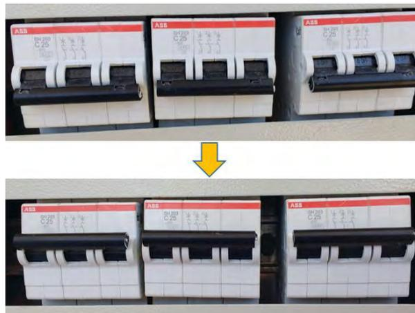
Figura 3.9. Proceso de activación de las llaves termo-magnéticas del tablero eléctrico.
