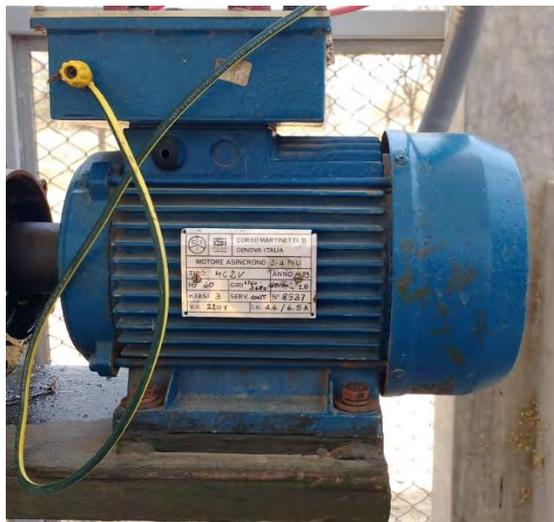
Figura 2.52. Motor trifásico del subsistema dosificador.
