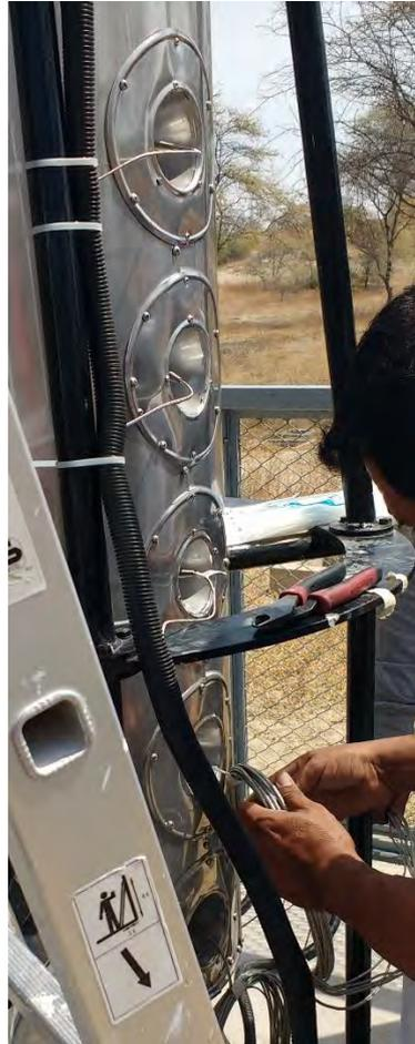
Figura 2.34. Proceso de unión de cablearía de los sensores en un conduit.
