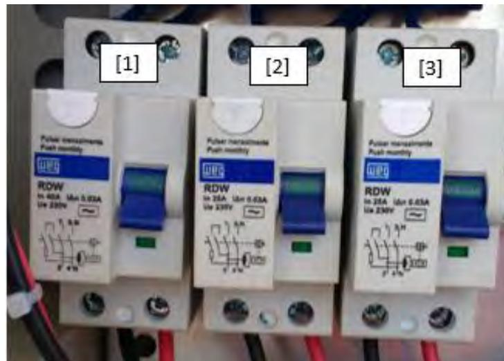
Figura 2.29. Diferenciales dentro del tablero de energía principal.
