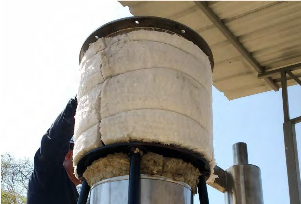
Figura 2.23. Primera capa del recubrimiento térmico.
