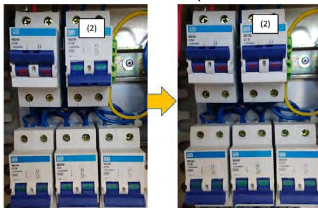
Figura 3.11. Proceso de activación de la llave del variador del sistema dosificador.
