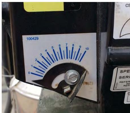
Figura 3.5. Posición en nivel 0 indicando que no hay ingreso de gas al quemador.
