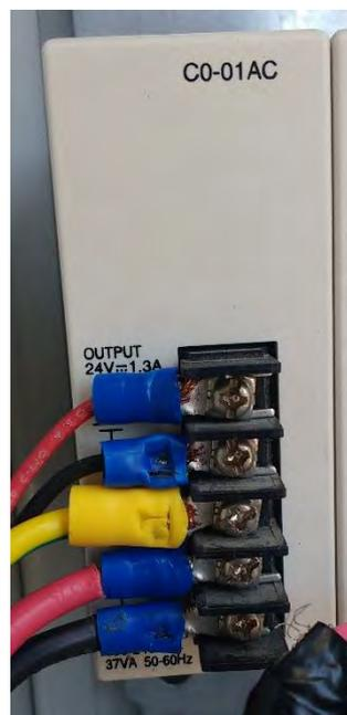
Figura 2.36. Fuente propia del PLC y sus demás componentes.
