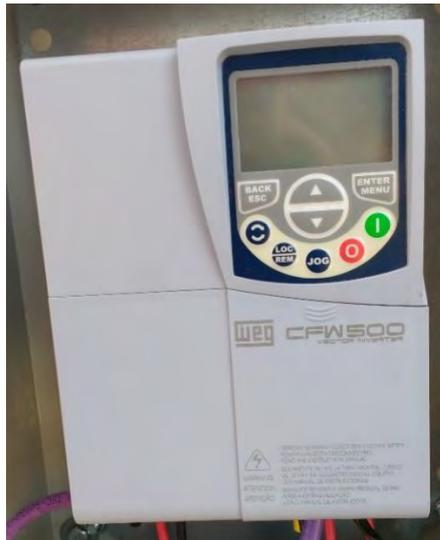
Figura 2.43. Variador de frecuencia del soplador.
