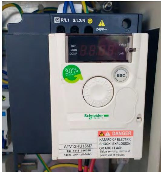
Figura 2.30. Variador de frecuencia del sistema dosificador de biomasa.
