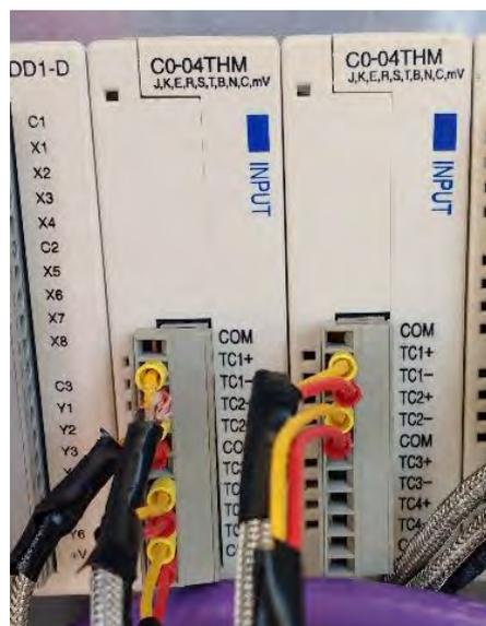
Figura 2.38. Módulos A/D para termocuplas.
