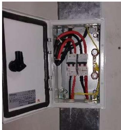
**Figura 72.** Tablero para el control de inversores trifásicos
