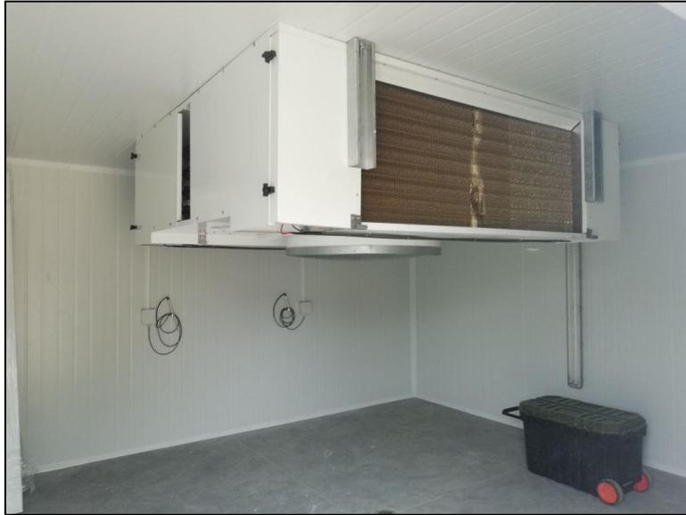
Figura 7. Fotografía del evaporador dentro de la planta piloto
