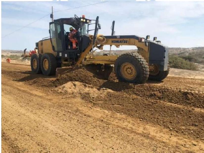
Figura 41. Conformación de la base estabilizada (suelo cemento) con motoniveladora, km 39+500.
