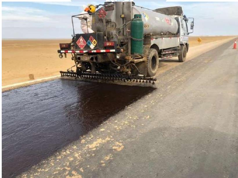
Figura 45. Curado del carril izquierdo a nivel de base estabilizada con cemento, km 23+600.
