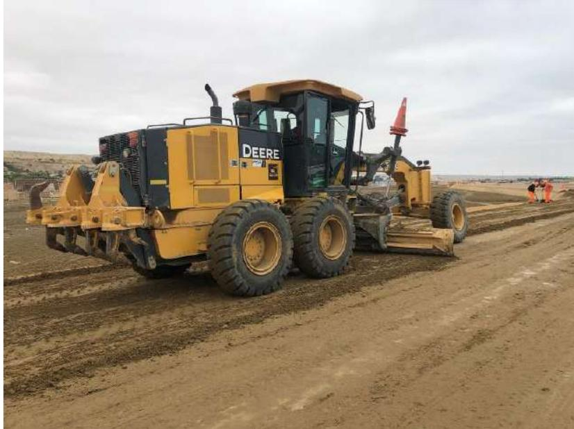
Figura 43. Perfilado de bombeos con motoniveladora en suelo cemento pre compactado.
