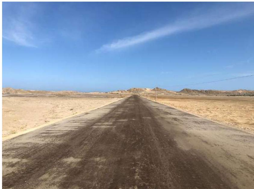
Figura 46. Superficie curada con emulsión y arena esparcida en la superficie antes de permitir el paso del tráfico.
