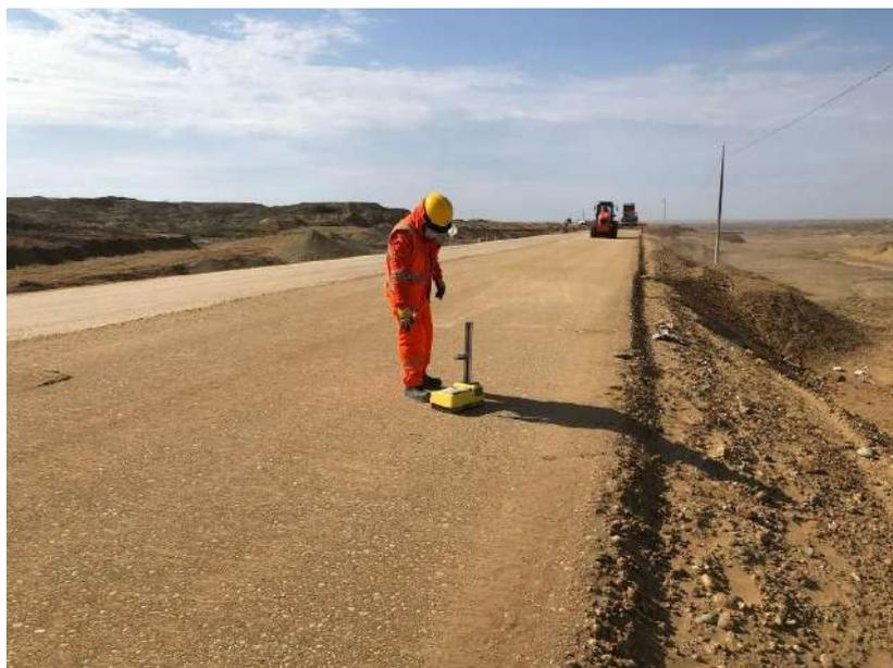
Figura 56. Determinación de densidad in situ con método nuclear
