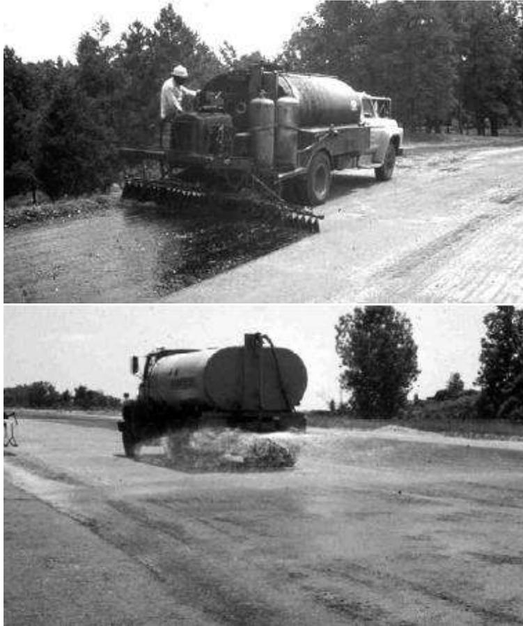
Figura 2. Curado de suelo cemento con emulsión asfáltica (arriba) y mediante aspersión de agua (abajo).
