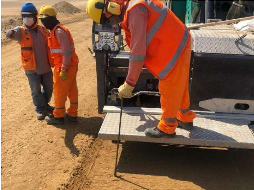
Figura 53. Control de espesores con escantillón previa compactación del material colocado.
