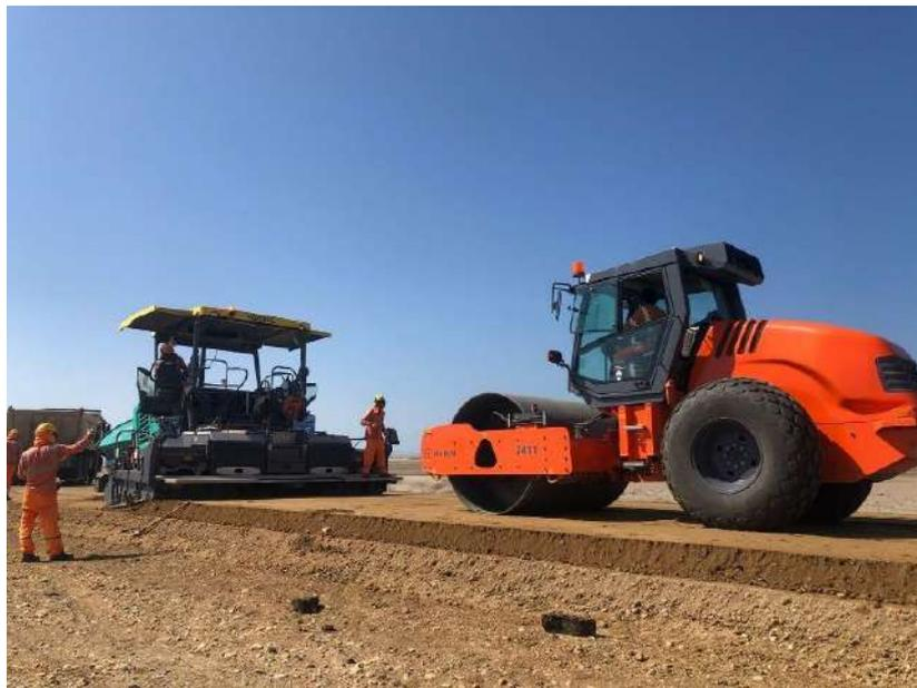
Figura 42. Rodillo liso en compactación inicial de suelo cemento recién colocado.
