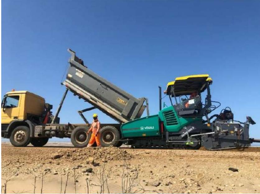
Figura 40. Colocación de la segunda capa de suelo cemento con esparcidora, km 45+600.
