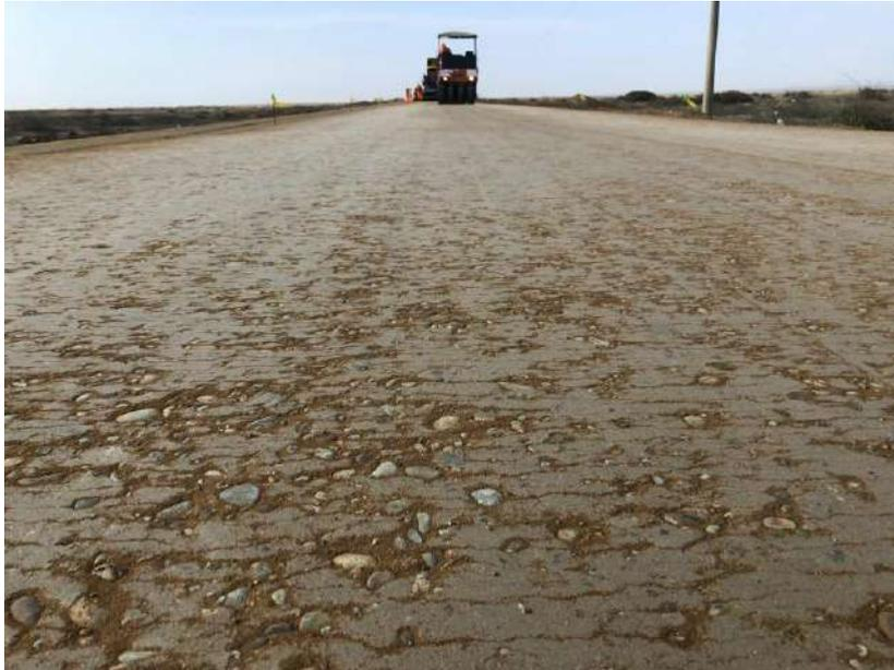
Figura 52. Superficie de suelo cemento de color homogéneo.
