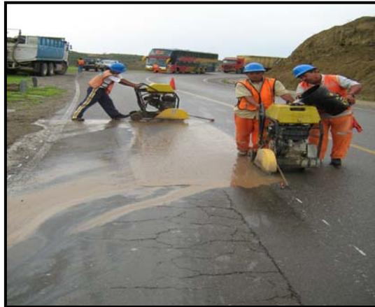
Foto 2.4 Cortado de la carpeta asfáltica
