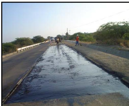
Foto 2.10 Imprimación asfáltica
