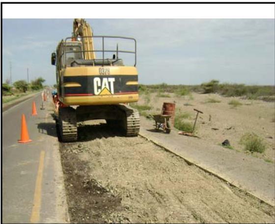
Foto 2.5 Remoción de la carpeta asfáltica existente
