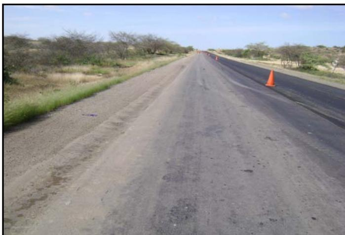
Foto 2.32 Limpieza del tramo a aplicar el micropavimento
