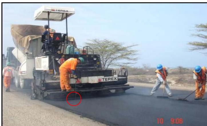
Foto 2.35 Verificación del espesor
