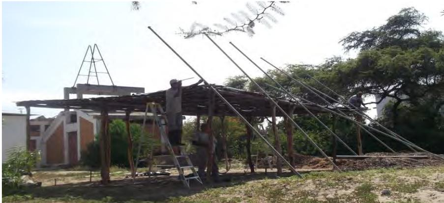
**Figura 2.3.** Reparación del techo de la compostera y colocación del plástico
