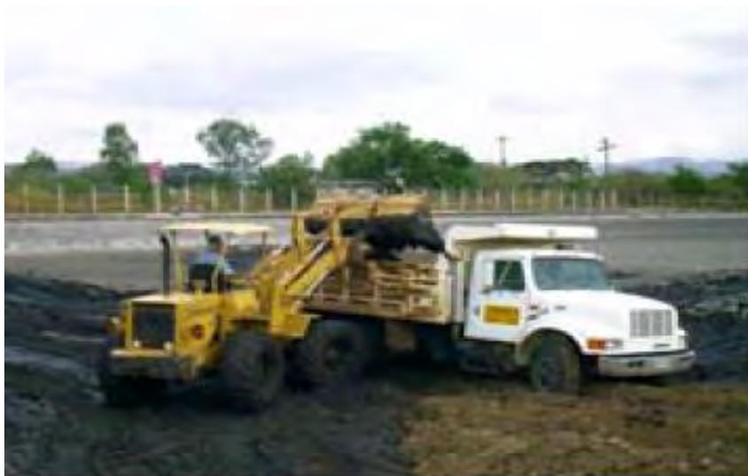
**Figura 1.7.** Retirando lodos de laguna.
