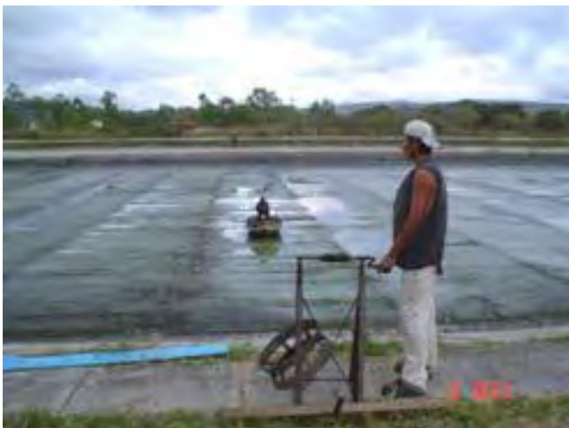
**Figura 1.5.** Estanque especial para secado de lodos.
