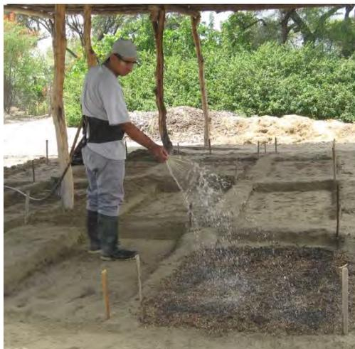
**Figura 2.10.** Colocación y regado de la primera capa de lodo.
