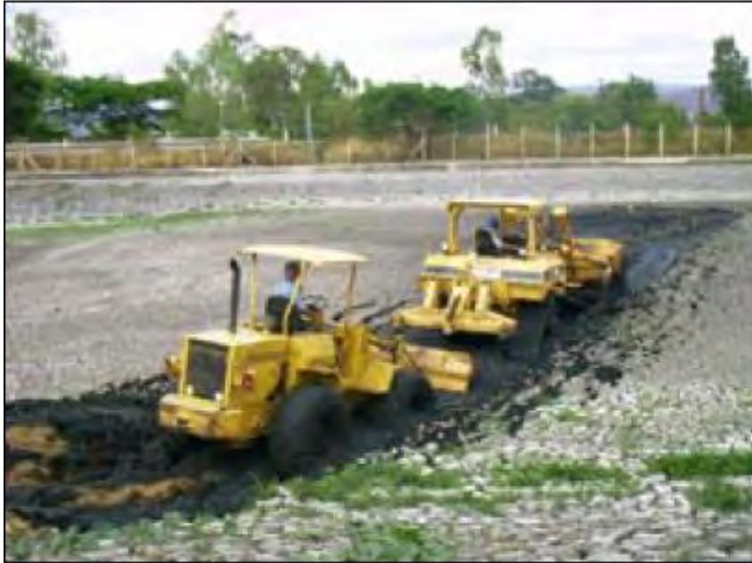
**Figura 1.6.** Recogiendo lodos con maquinaria pesada.
