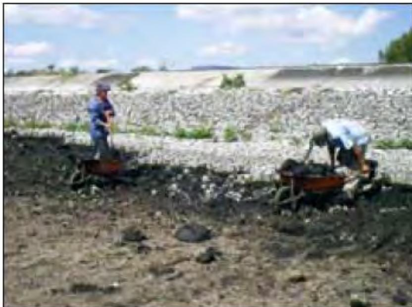
**Figura 1.8.** Cargando lodos con carretilla y pala.
