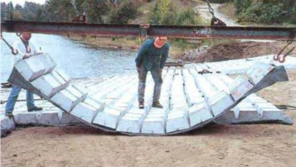
**Figura 16.** Sistemas cable - concreto
