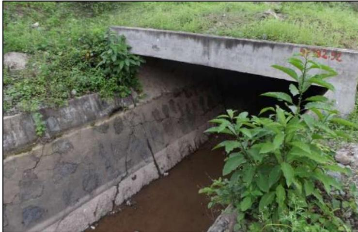
Figura 19. Fisuras y erosión en canal.
