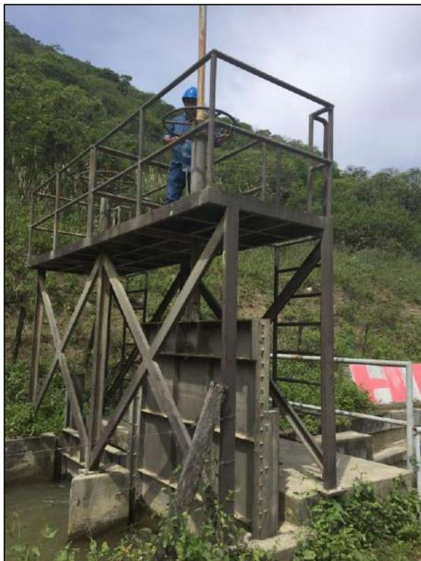
Figura 17. Compuerta de nave del desarenador accionada manualmente.
