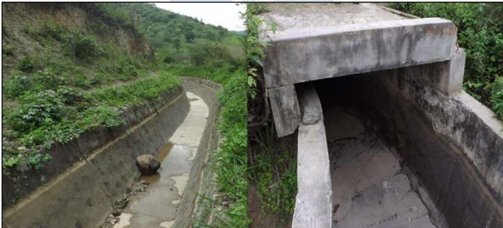
Figura 20. Presencia de piedras y fisuras en el canal.
