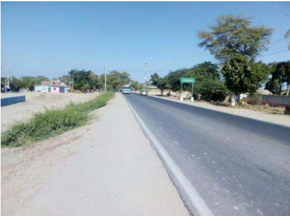
No tiene berma asfaltada, lo que permite el deterioro de la carretera. Según Bautista (2021), el uso de bermas en una carretera ayuda a proteger la calzada contra posibles erosiones, proporciona un ancho adicional de la vía y mejora la visibilidad en los tramos curvos.
