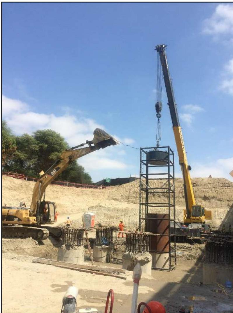
Figura 39. Prueba de Carga Dinámica en el pilote de prueba del Pilar 05
