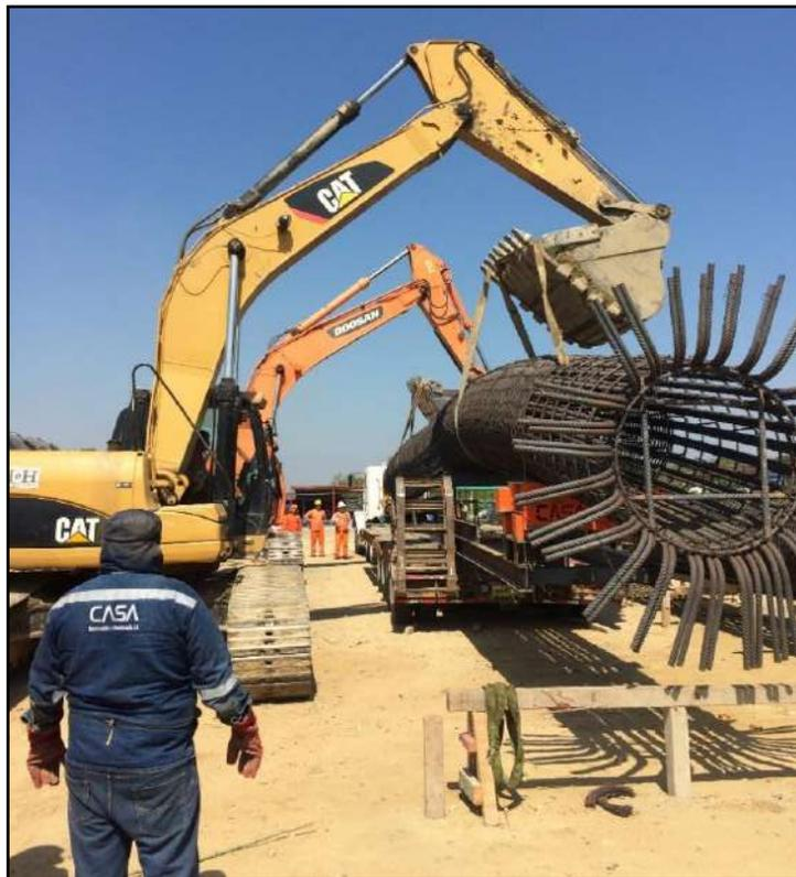
Figura 28. Posicionamiento de la armadura en el camión plataforma
