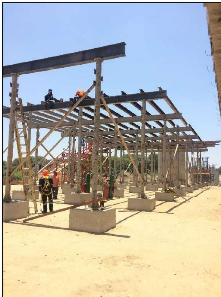
Figura 45. Colocación de Vigas Secundarias en el Segundo Tramo
