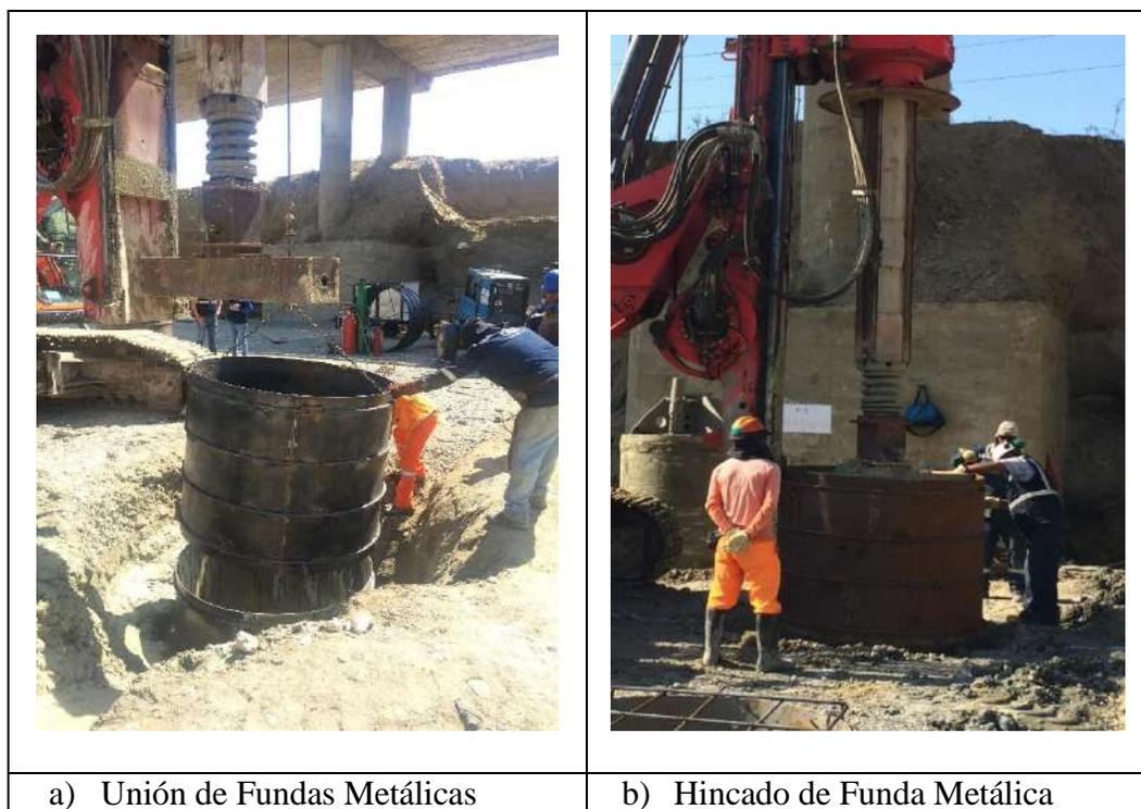
Figura 27. Colocación de Fundas Metálicas
