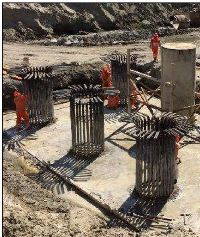
Figura 37. Descabezado completo en Pilotes del Pilar 03
