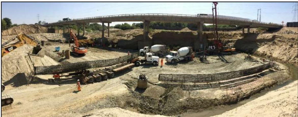
Figura 15. Plataforma de trabajo para Pilares 01 y 02
