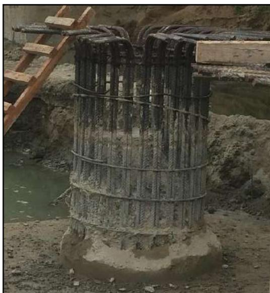
Figura 36. Pilote parcialmente descabezado.
