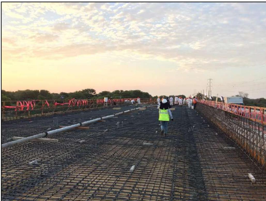
Figura 52. Losa Superior encofrada y armada preparada para el vaciado
