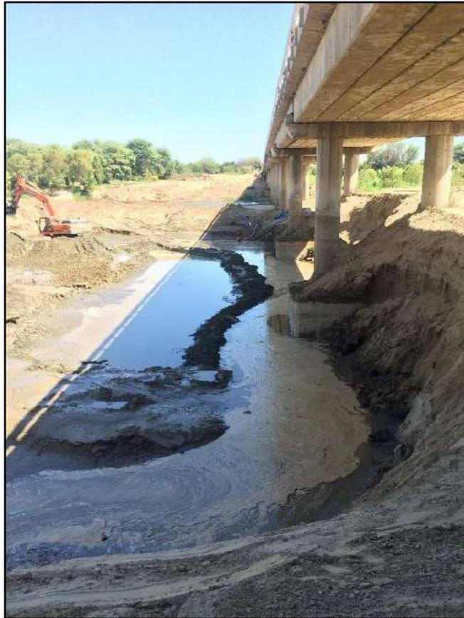
Figura 14. Excavación de Plataforma para Pilares 01 y 02
