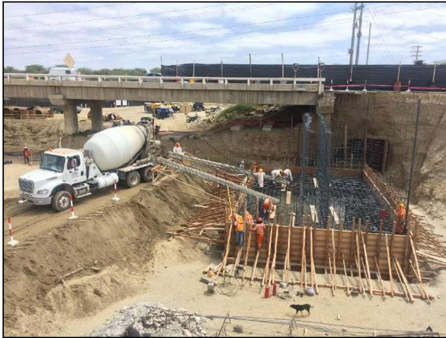
Figura 43. Vaciado de Zapata Estribo Izquierdo
