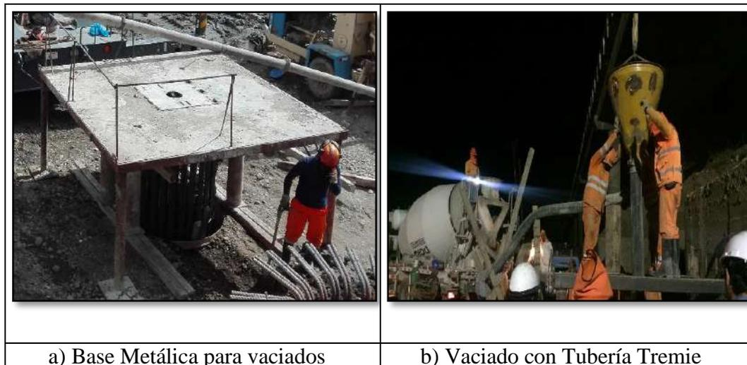
Figura 33. Instalación de Tubería Tremie
