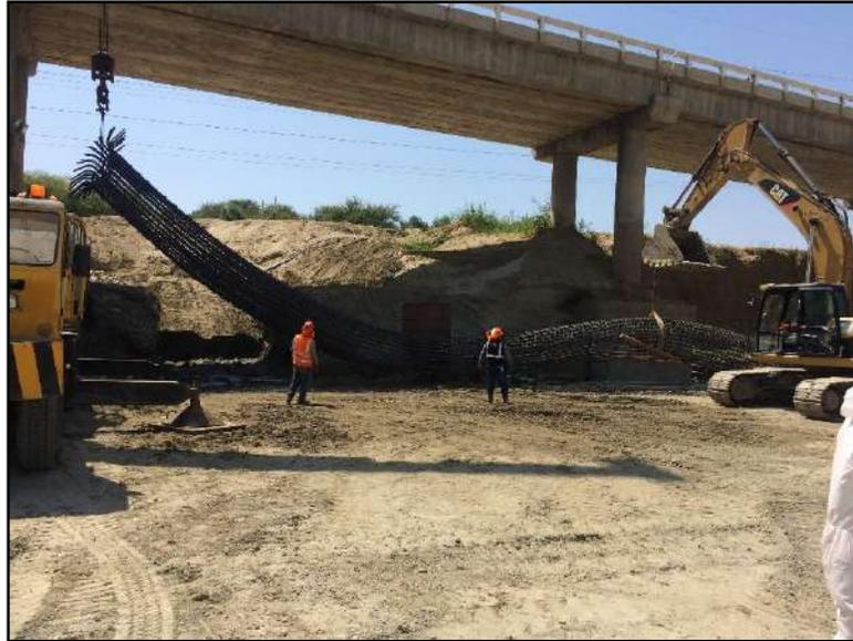
Figura 30. Izaje de armadura asistido por Excavadora
