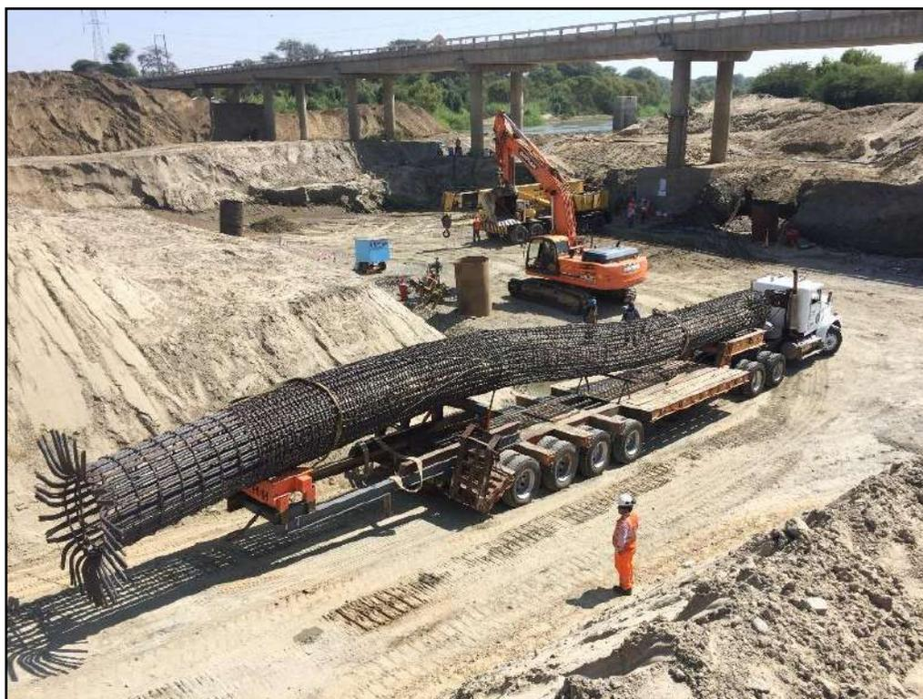
Figura 29. Ingreso de la armadura en la plataforma de pilotaje
