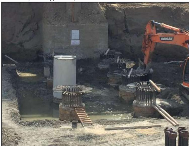
Figura 35. Eliminación de material de mejoramiento, y retiro de fundas metálicas
