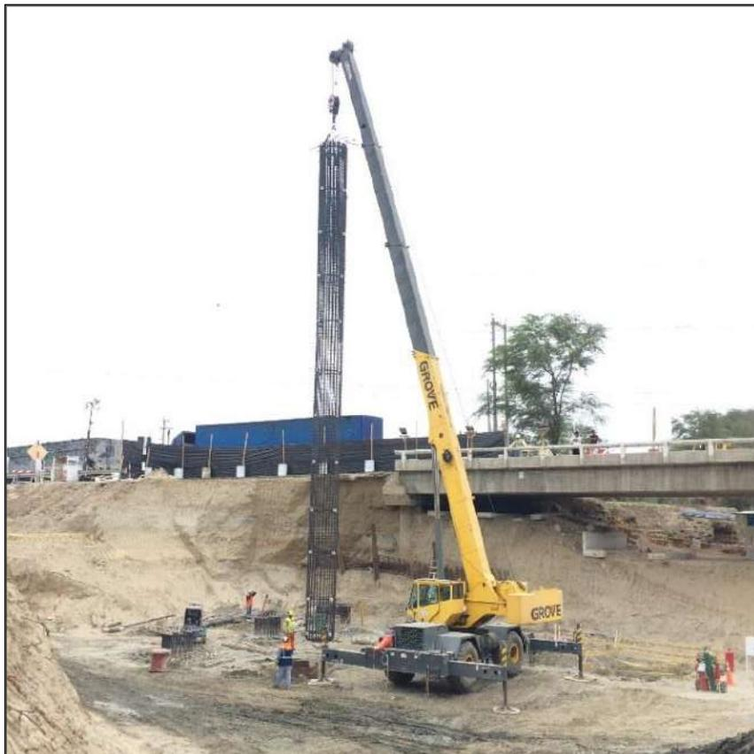
Figura 31. Izaje de armadura del Estribo Derecho con la Grúa Grove RT 600 E
