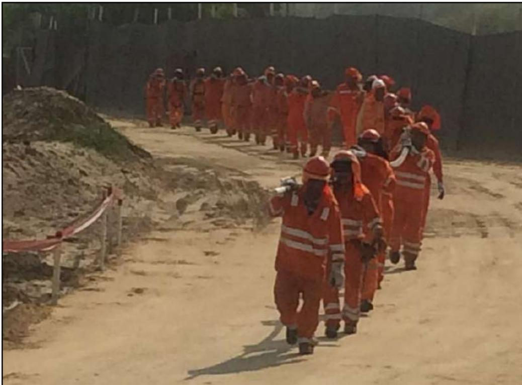
Figura 47. Transporte de cables de postensado
