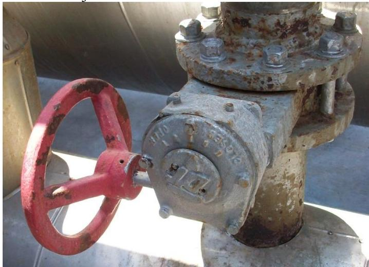
Figura 2. 2. Válvula reguladora de ingreso de vapor
