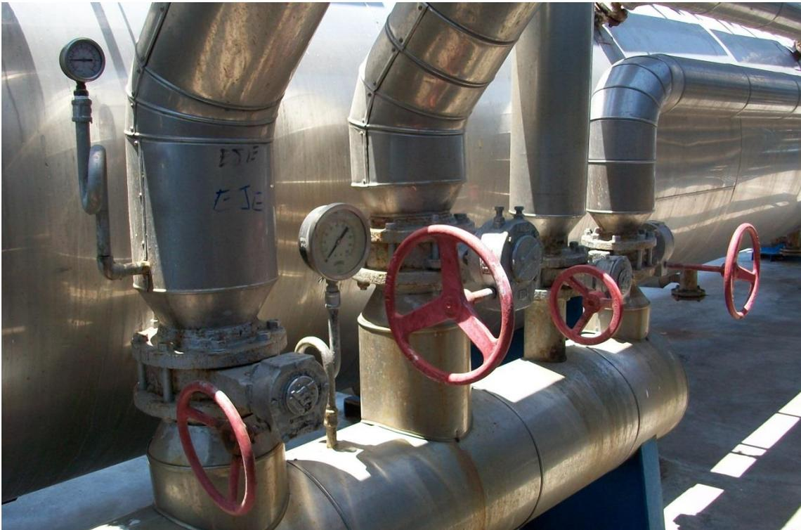
Figura 2. 13. Manifold de alimentación de vapor en un cocinador
