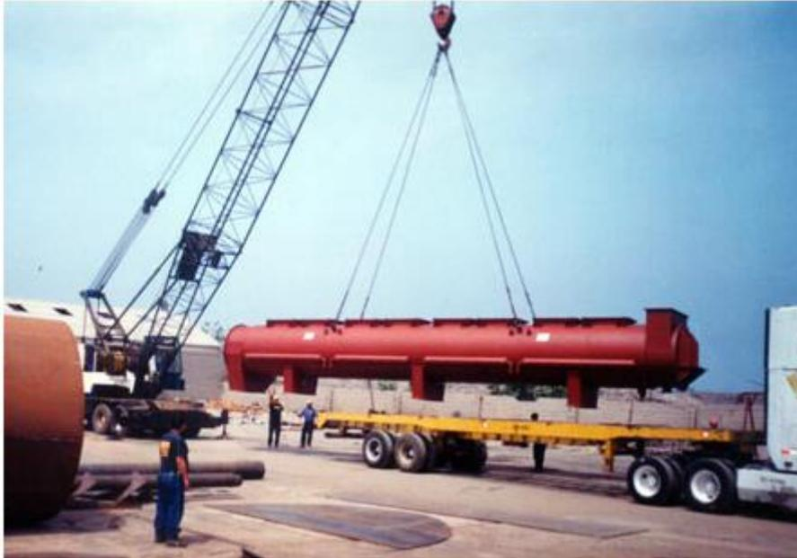
Figura 1. 3. Montaje de un cocinador
