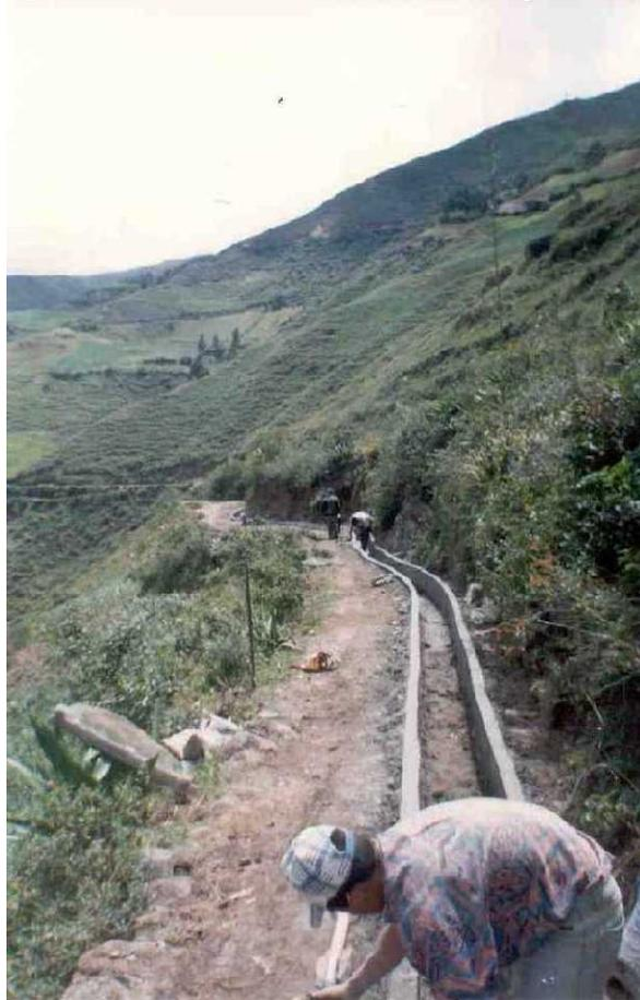
**Figura 2.7 Construcción de los taludes del canal.**
