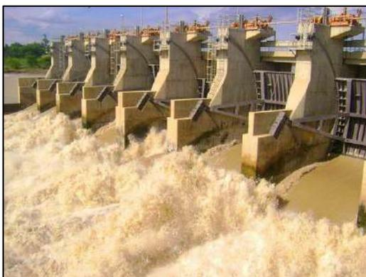
**Ilustración 1-10 Aliviadero de compuertas de presa derivadora Sullana.**
