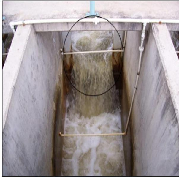
Imagen N° 21 Solución del coagulante distribuida mediante tubería perforada o flauta
