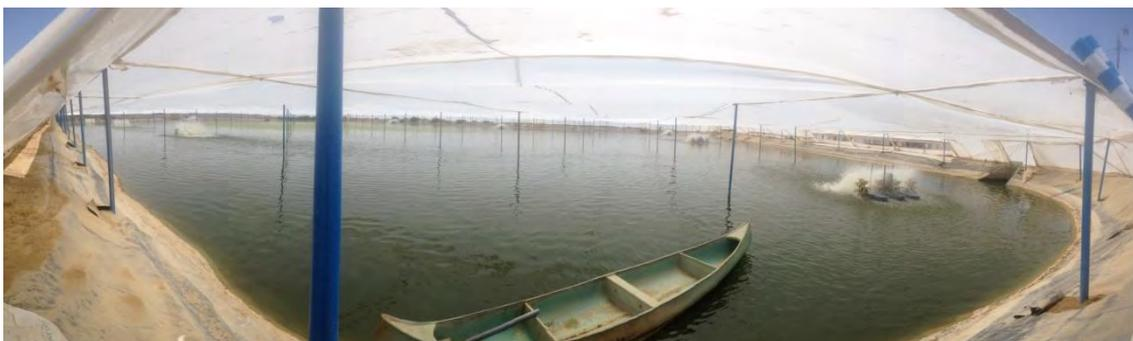
Figura 4. Piscina recubierta de geomembrana y techada con plástico UV
