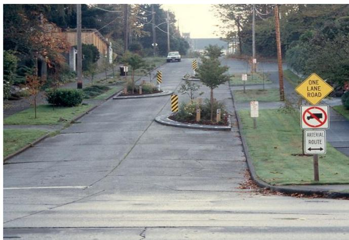
**Figura 5.** Uso de chicanas para controlar la velocidad
