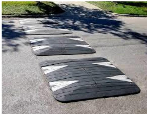
**Figura 28.** Amortiguadores de velocidad
