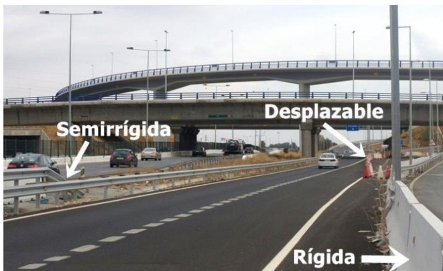
**Figura 7.** Barreras laterales de seguridad
