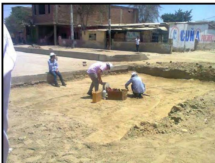
**Figura 10.** Ejemplo de una capa de sub rasante en una vía urbana en Piura.
