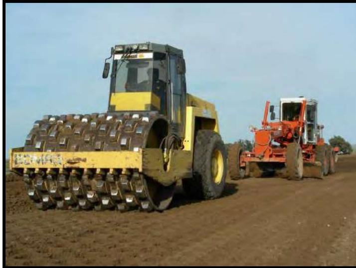
**Figura 11.** Estabilización por compactación usando un rodillo “pata de cabra”.
