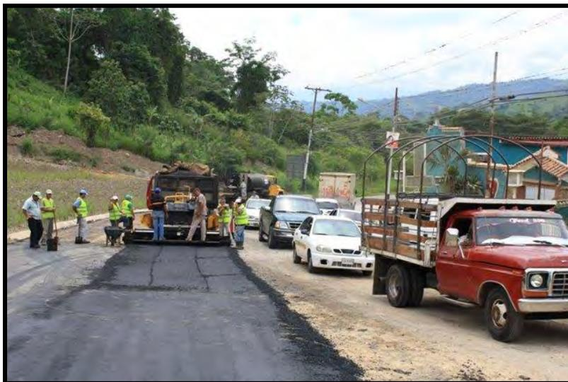
**Figura 15.** Estabilización con asfalto.
