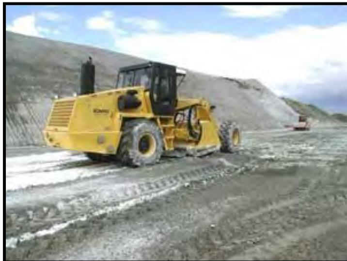
**Figura 14.** Estabilización de suelo con cal.
