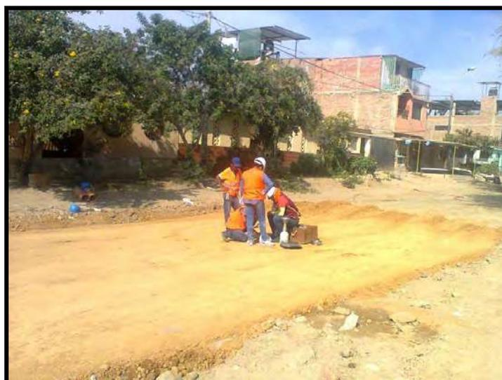
**Figura 9.** Ejemplo de una capa de Sub base en una vía urbana en Piura.
