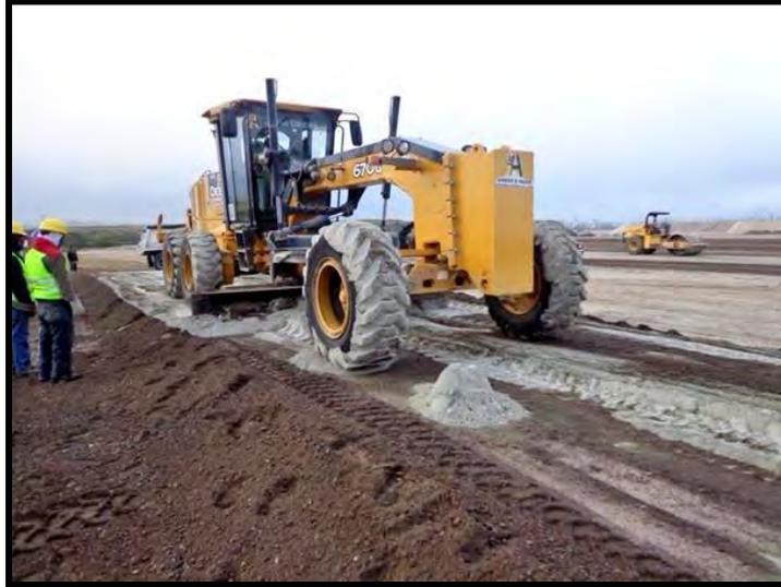
**Figura 13.** Estabilización con cemento.
