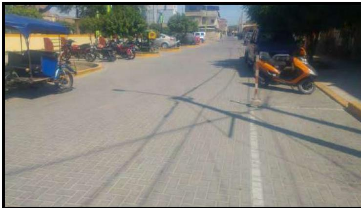
**Figura 6.** Ejemplo de un pavimento semirrígido, de bloquetas de concreto.
