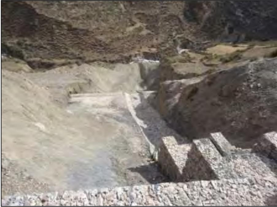
**Fig. 4.4 - Tratamiento del talud inferior a la salida de la alcantarilla**
