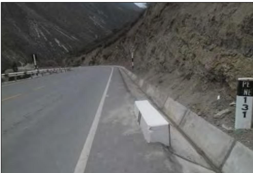
**Figura 1.7 - Cunetas de concreto simple**
