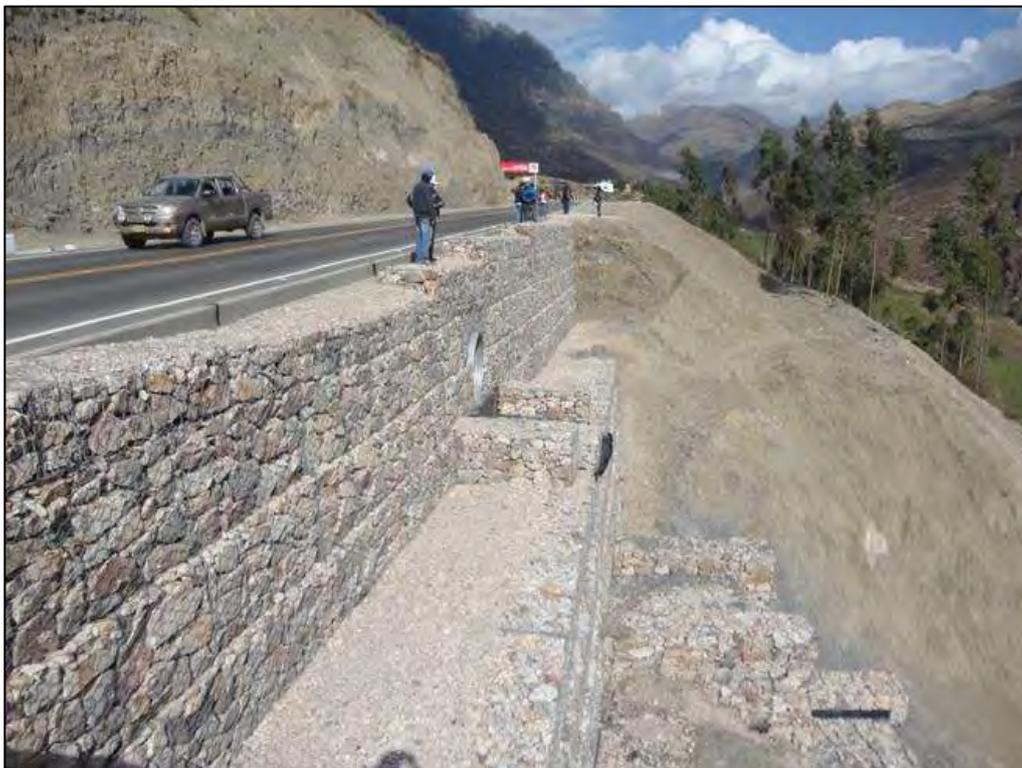
**Fig.3.1 - Protección con gaviones**
