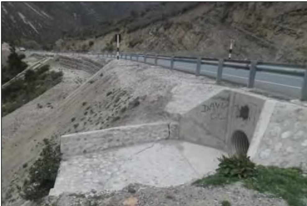
**Figura 1.6 - Alcantarillas metálicas con enrocado**
