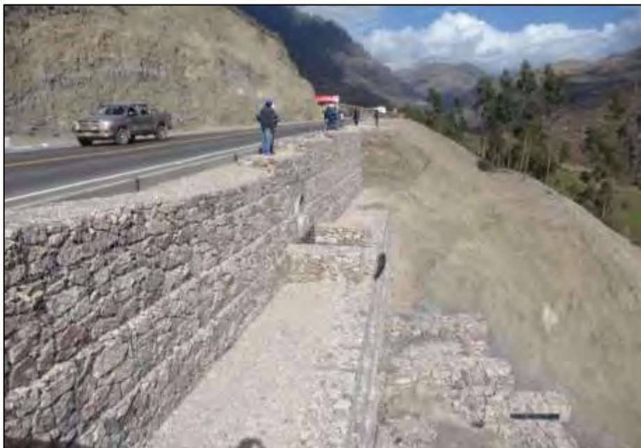
**Fig. 4.3 - Solución a la alcantarilla en la progresiva 132+946**
