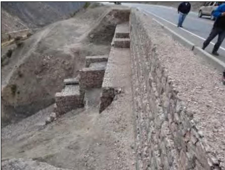
**Fig. 4.5 - Tratamiento del talud inferior a la salida de la alcantarilla**
