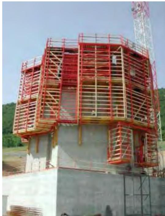
**Figura 1-19: Encofrado para una columna de sección variable<sup>20</sup>**
