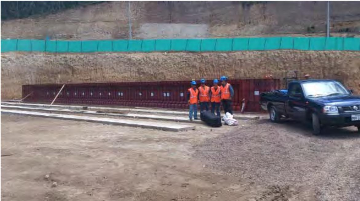
**Figura 1-12: Encofrado de viga post-tensada (fabricada y diseñada por Metalshop).<sup>11</sup>**
