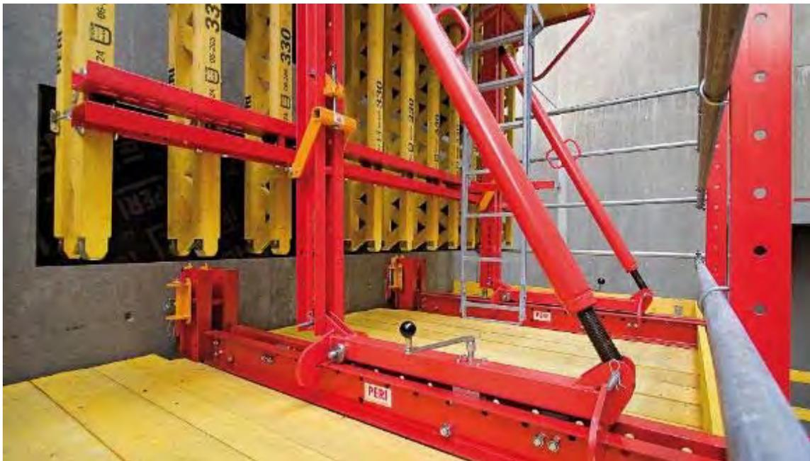
**Figura 1-24: Vista de plataforma de encofrado PERI CB climbing formwork.<sup>25</sup>**
