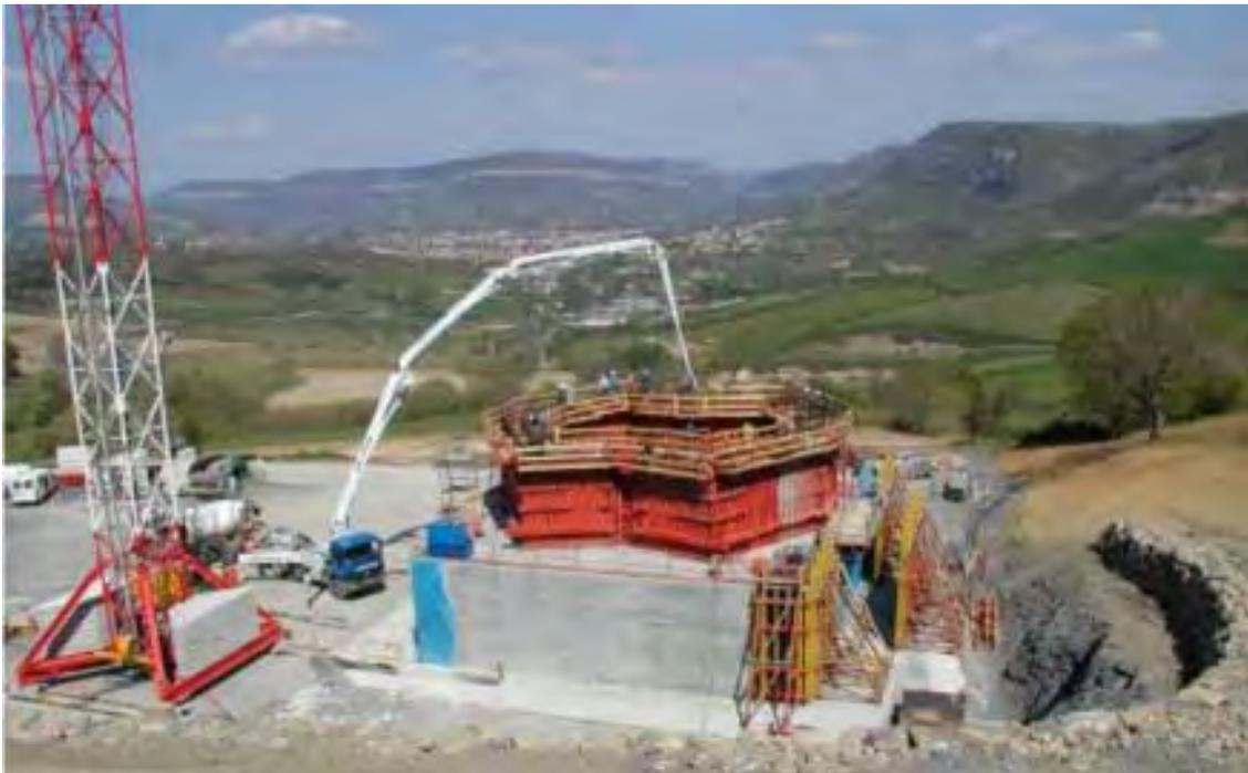
**Figura 1-16: Inicio del proceso de fundición del pilar (Viaducto Milau - Francia).<sup>17</sup>**
