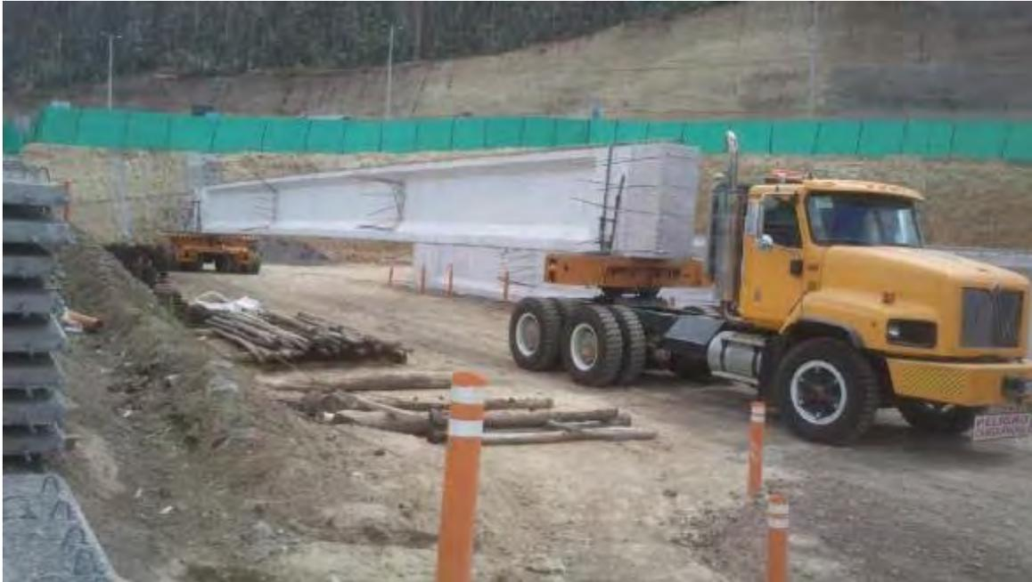
**Figura 1-14: Detalle de viga lista para el montaje.<sup>13</sup>**
