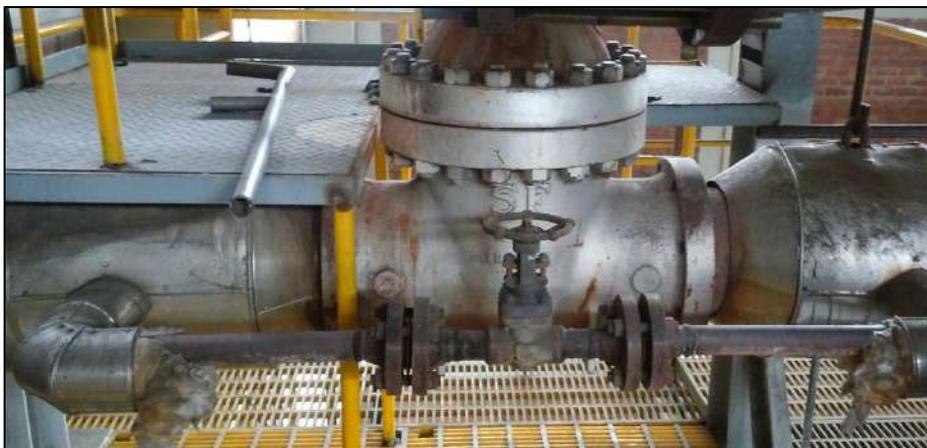
Figura 51. Válvula de 8'' de ingreso de vapor hacia la turbina.
