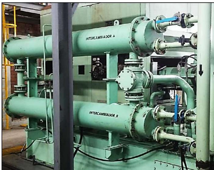
Figura 45. Intercambiadores aceite – agua de la turbina.
