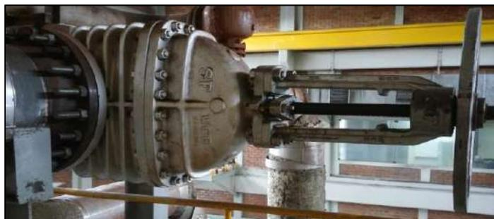
Figura 52. Válvula de 20'' de salida de vapor hacia la turbina.
