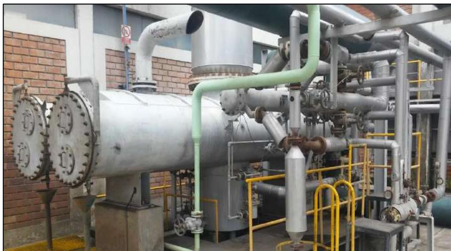
Figura 88. Condensador de la turbina TMC5000.
