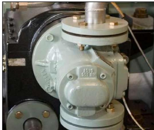
Figura 74. Bomba mecánica conectada al eje de baja rotación del reductor.
