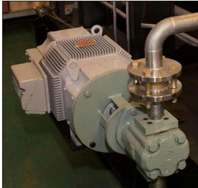
Figura 44. Bomba de emergencia de corriente continua.
