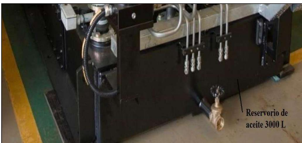
Figura 79. Reservorio de 3000 L de aceite ubicado debajo de la turbina.
