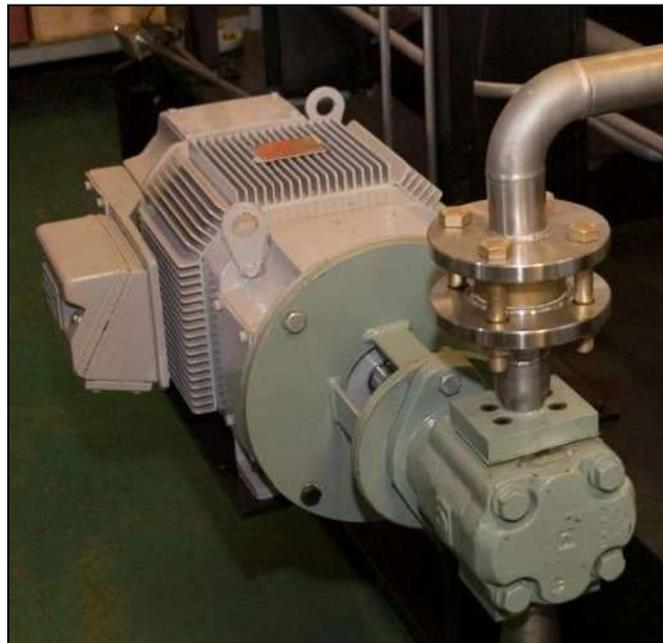
Figura 84. Bomba de emergencia de corriente continua.
