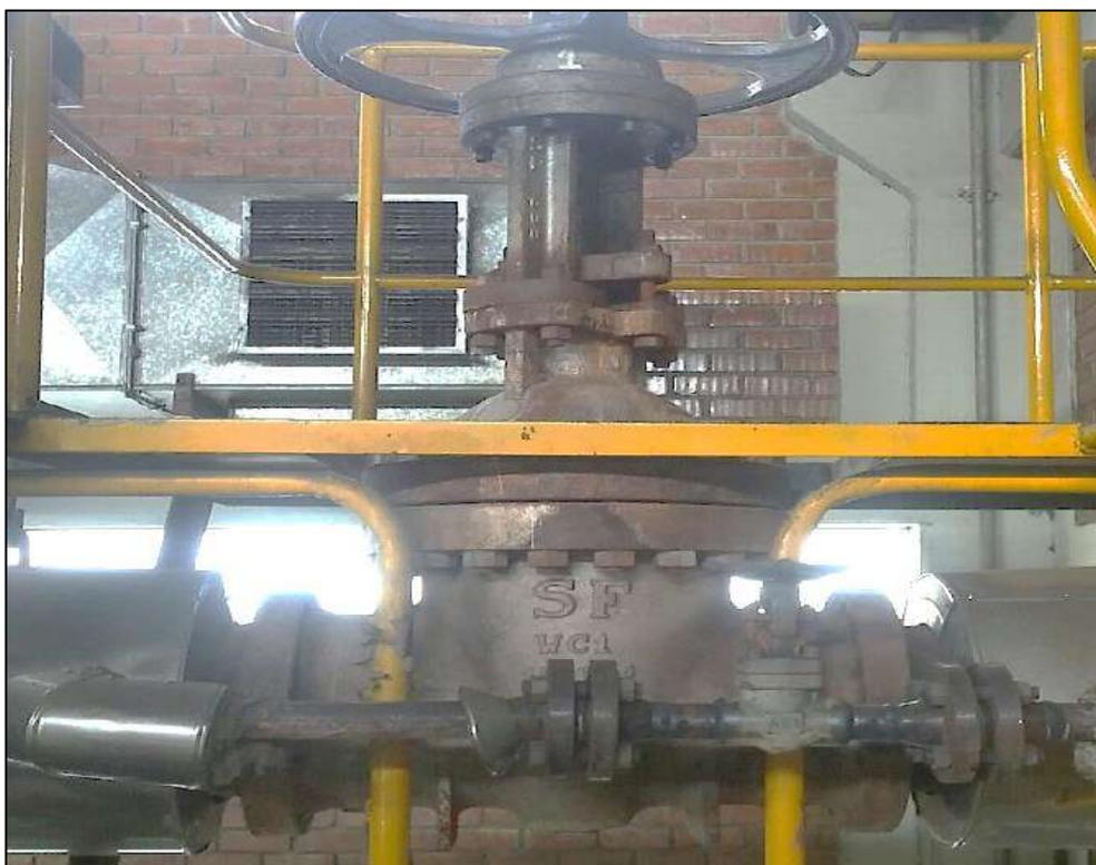
Figura 95. Válvula de 6'' de ingreso de vapor hacia la turbina.
