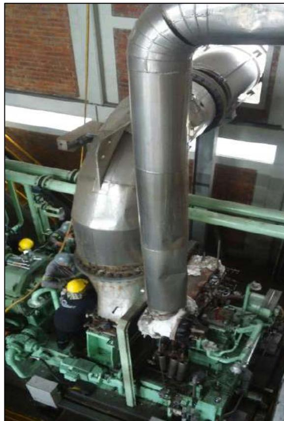
Figura 67. Líneas de entrada y salida de vapor de turbina de condensación.
