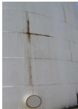
**Fugas de biodiesel a través de los remaches, detectadas durante la inspección del tanque**
