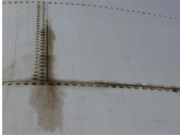
**Fugas de biodiesel a través de los remaches, detectadas durante la inspección del tanque**
