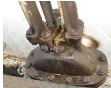
**Fugas de biodiesel en válvulas del sistema de distribución del tanque 299**
