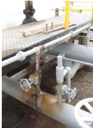
**Fugas de biodiesel en válvulas del sistema de distribución del tanque 299**
