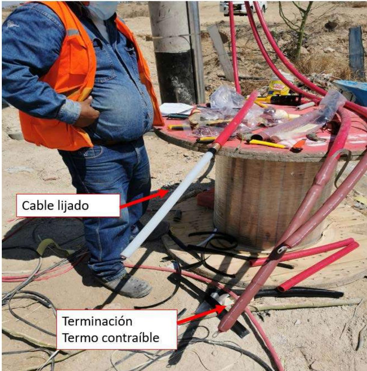
**Figura 37. Colocación de las terminales de los cables subterráneos**
