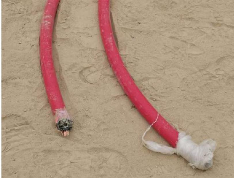
**Figura 35. Lijado del cable para colocación de termo contraíbles**
