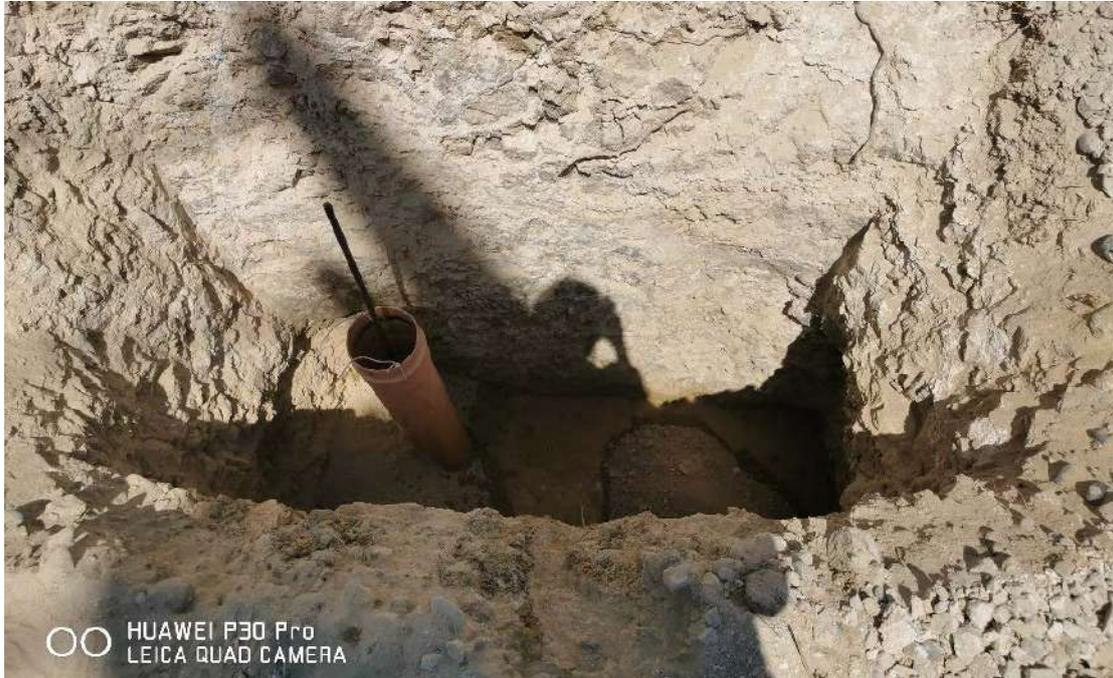
**Figura 18. Tubería y puesta a tierra ya colocada**
