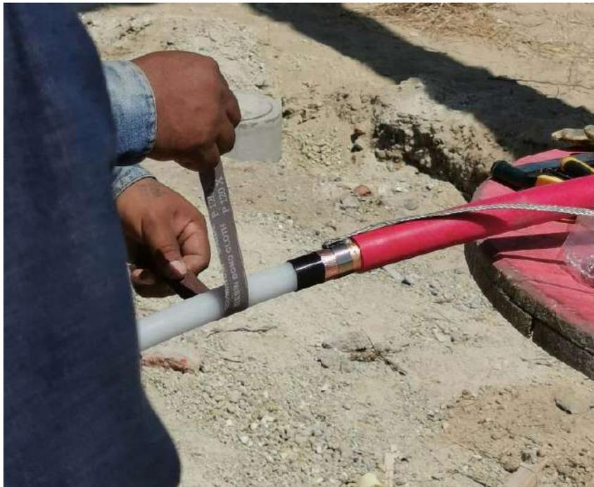
En la Figura 36 se puede apreciar en la parte izquierda el cable lijado y en la parte derecha el cable ya recubierto con termo contraíble. El cable termo contraíble se coloca con pistola de calor. La Figura 37 muestra la colocación de las terminales de los cables.
