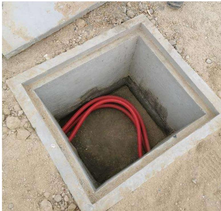
**Figura 32. Ductos para pasar el cable subterráneo**
