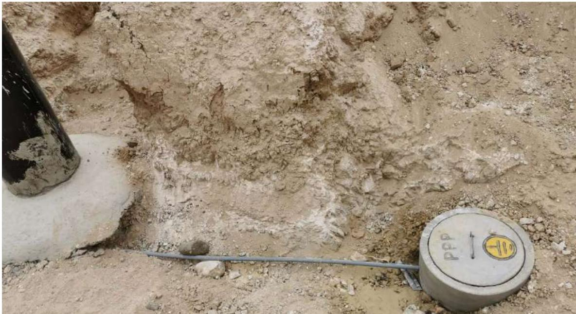
**Figura 19. Cable para puesta a tierra**
