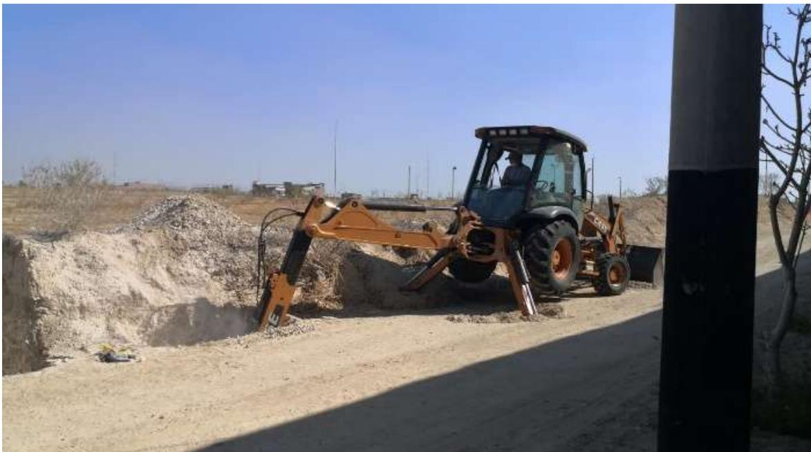
Como se aprecia en la Figura 5 se debe tener un hoyo con la profundidad suficiente para asentar correctamente el poste.
