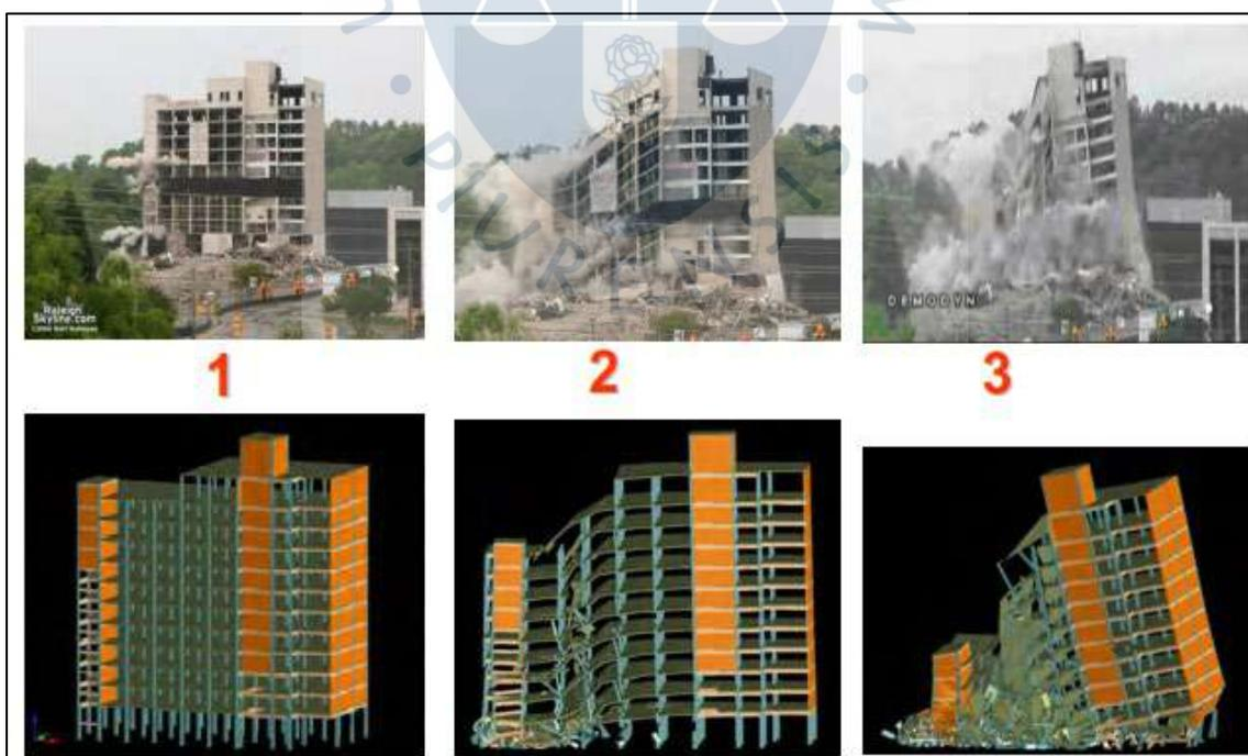
**Figura 13. Comparación entre la secuencia de demolición real y la simulación numérica en ELS del hotel Sheraton**
