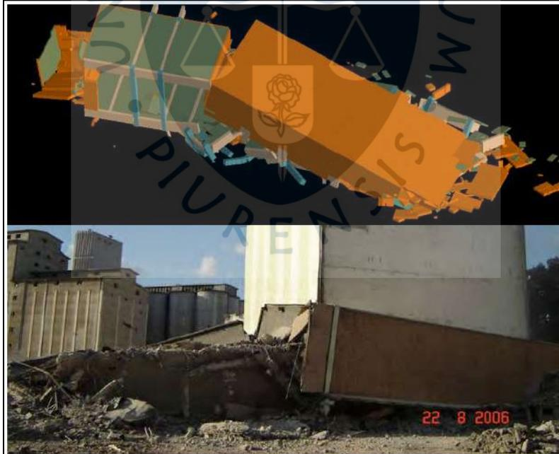
**Figura 15. Comparación entre la simulación del colapso y el colapso real del edificio**
