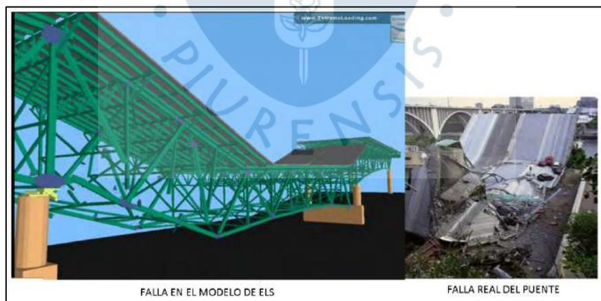
**Figura 17. Comparación entre la simulación del colapso del puente en ELS y el colapso real del puente en Minneapolis**
