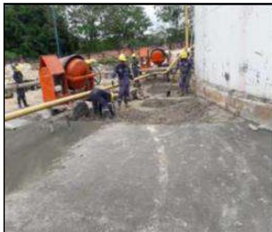
**Figura 4.** Suelo estabilizado – Tanque 332-T-7.
