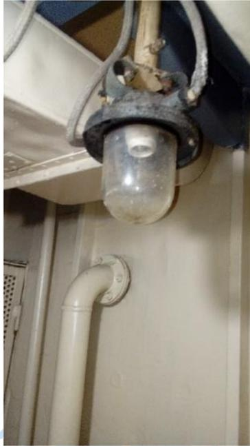
**Figura 12** Fanal colocado para la protección de los focos de abordó
