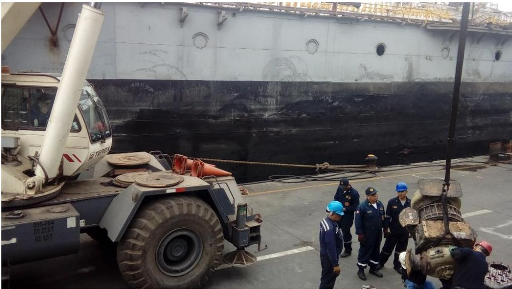
**Figura 2** Transporte de una pieza de motor de babor con apoyo de una grúa del SIMA
