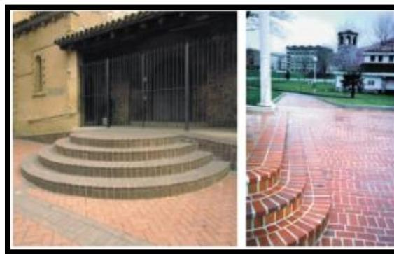
**Figura 6.** Escaleras de adoquines de concreto
