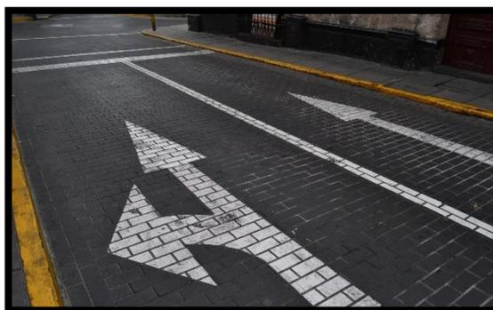
**Figura 4.** Pista de adoquines de concreto
