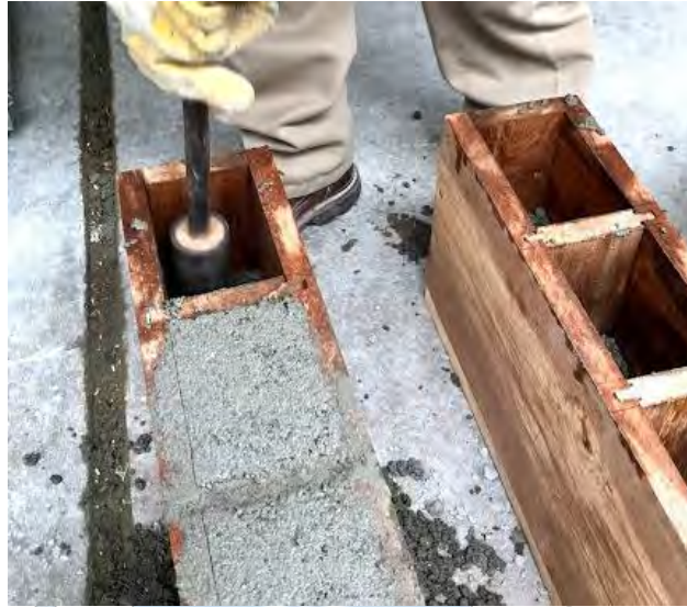
Figura 56. Colocación en moldes y compactación
