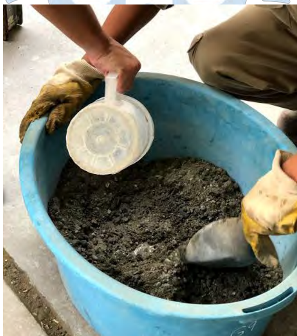
Figura 55. Mezcla de materiales
