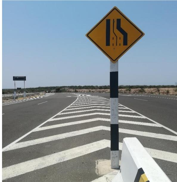
Figura 61. Señal de advertencia de un cambio en el número de carriles en el intercambio Vía de Evitamiento Sur Piura – Panamericana Norte.
