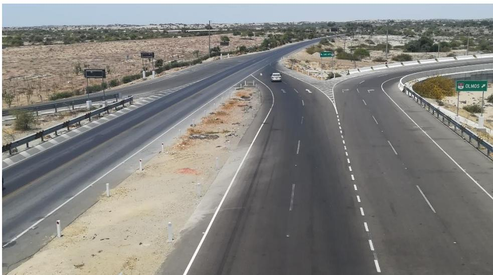
Figura 62. Sección de conflicto en transición de doble calzada a una calzada en Panamericana Norte.
