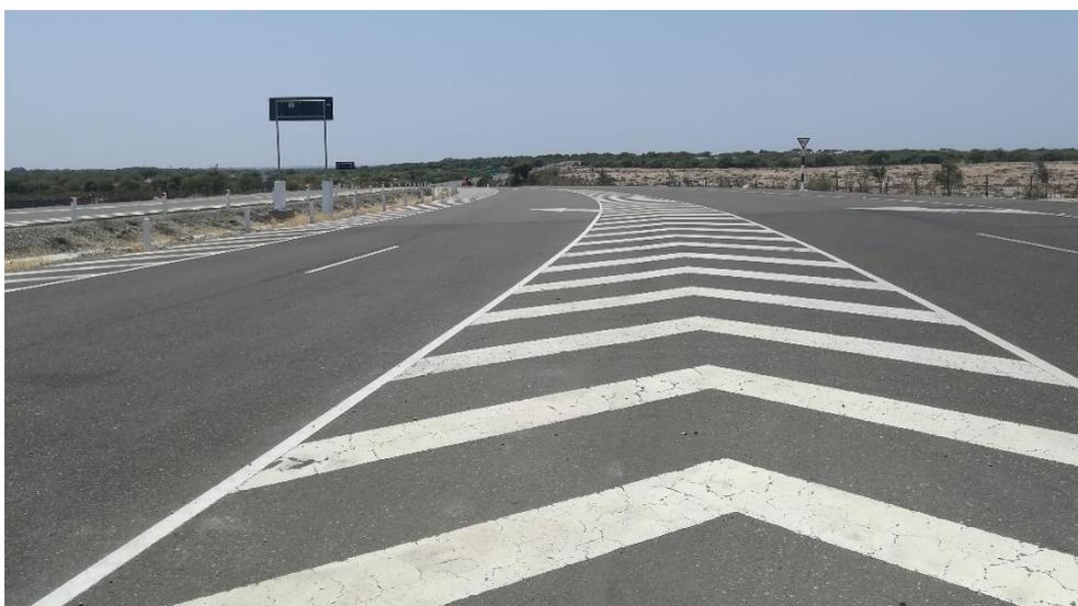
Figura 60. Demarcación de área cerrada y transición en el número de carriles en el intercambio Vía de Evitamiento Sur Piura – Panamericana Norte.
