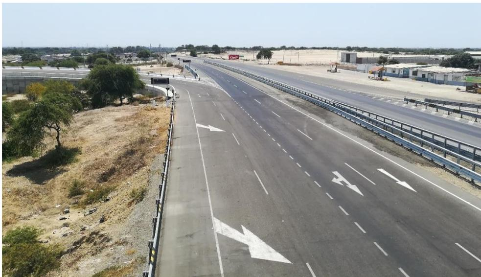
Figura 57. Carriles auxiliares en la entrada del ramal 1 del intercambio Vía de Evitamiento Sur Piura – Panamericana Norte.
