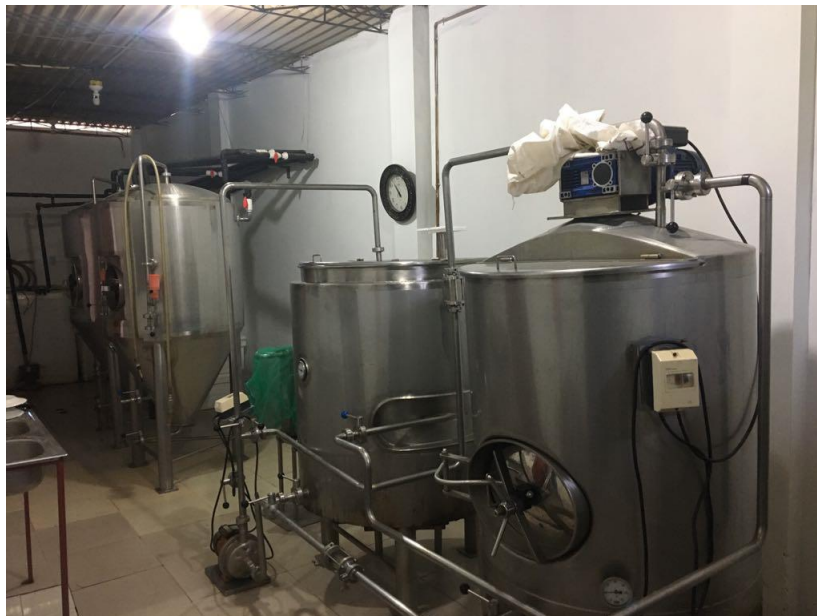
Ilustración 32. Equipos de la planta Imperio
