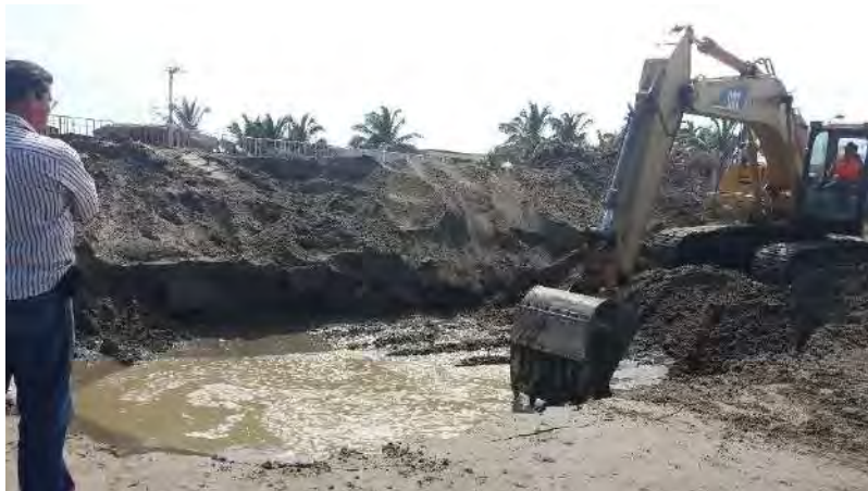
Figura 6. 3. Excavación de zanjas
