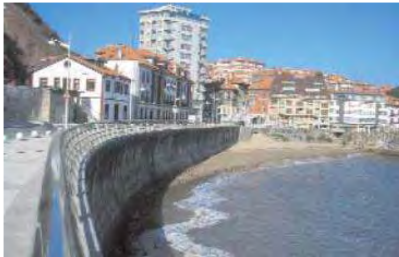
Figura 2. 2. Muro botaolas, paseo marítimo y carretera de acceso, Fuente: (Cimbra, 2010).
