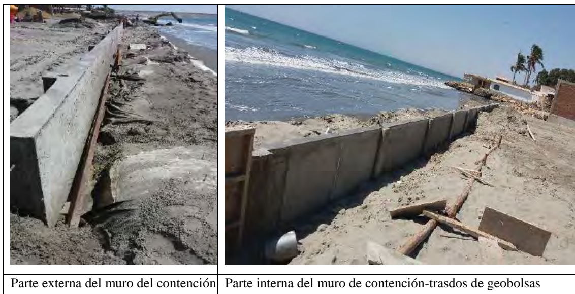
Fotografía D1. Vista externa e interna del muro de contención
