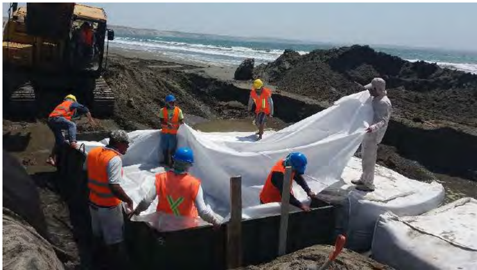
Fotografía C4. Habilidad y colocación de geobolsa dentro del encofrado
