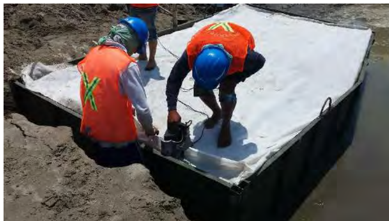
Figura 6. 10. Cierre de geobolsa con cosedora manual
