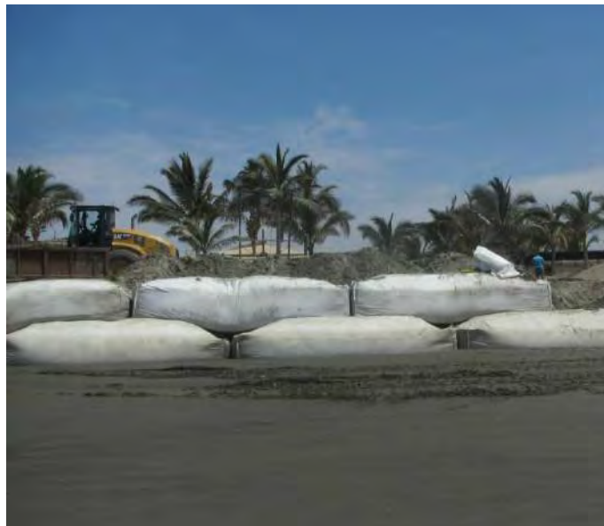
Figura 2. 10. Vista frontal del revestimiento flexible con geobolsas, Colán-Piura, Fuente: Autor
