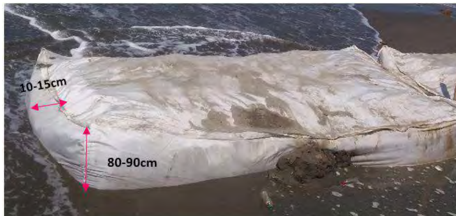
Figura 6. 19. Ensanchamiento y asentamiento de geobolsas
