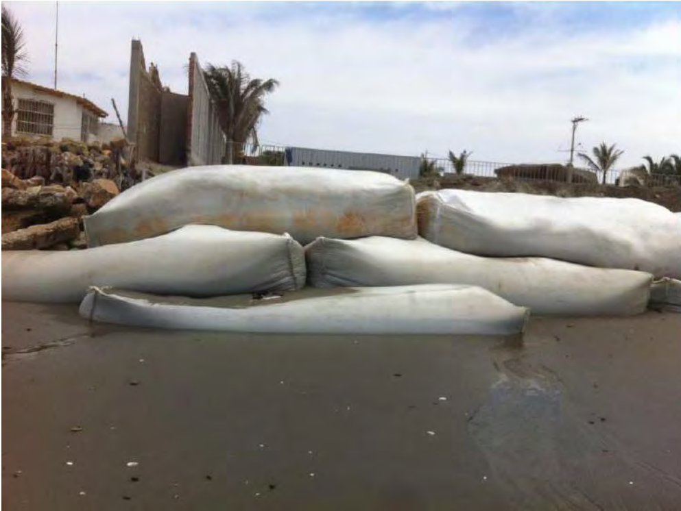
Fotografía C8. Geobolsas en esquina norte del local Costa-Bonita.
