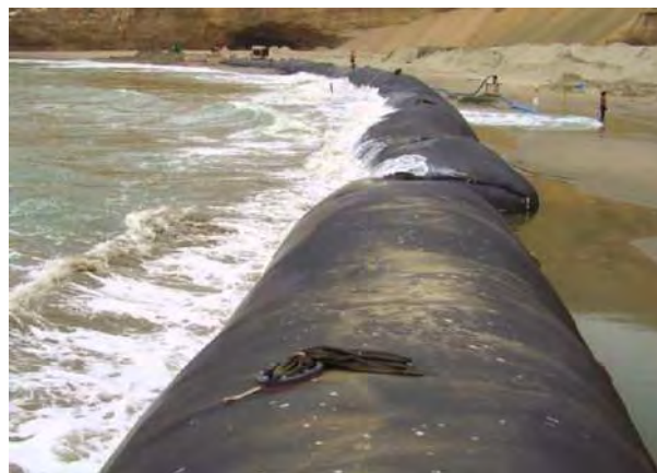
Figura 2. 9. Geotubos colocados paralelos a la línea de la costa, Fuente: http://www.evi.com.mx/evicom/prod_geotubo_marino_proteccion_costera.html
