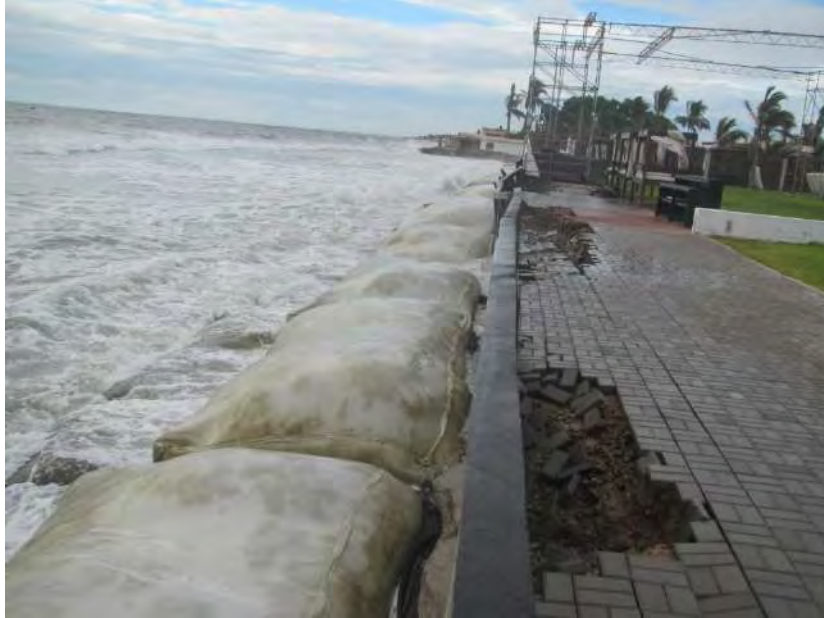
Fotografía D2. Vista plataforma del local Costa Bonita
