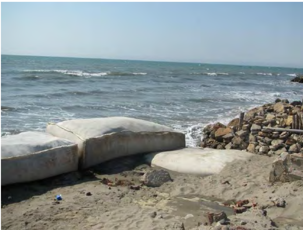
Fotografía C9. Geobolsas en esquina norte del local.
