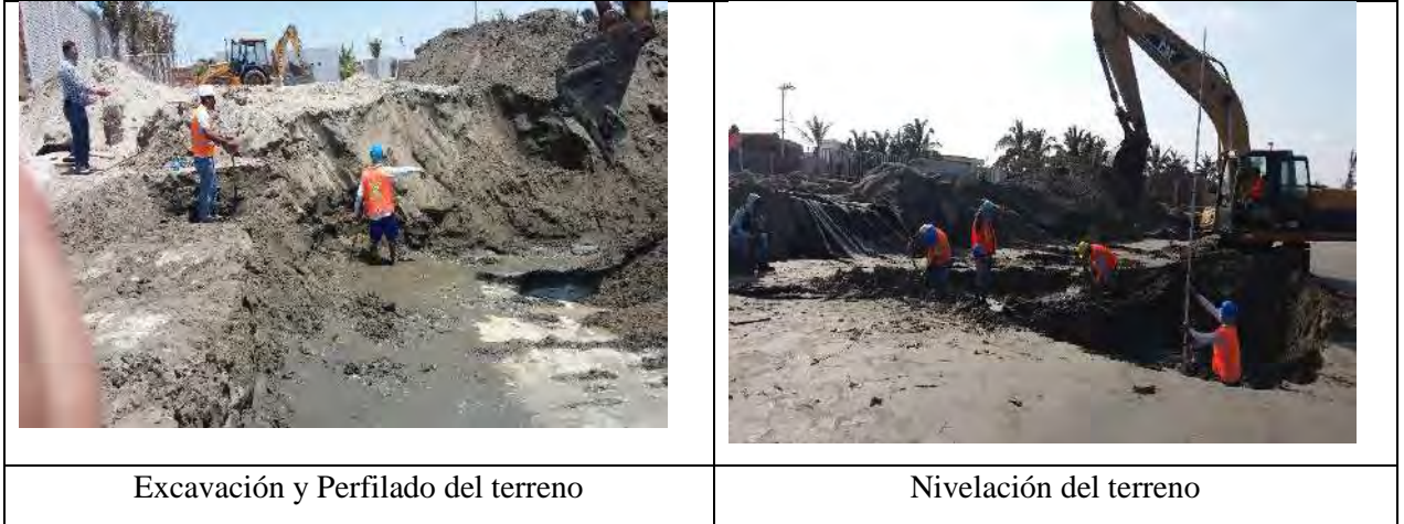
Fotografía C1. Actividades de excavación, perfilado y nivelación del terreno
