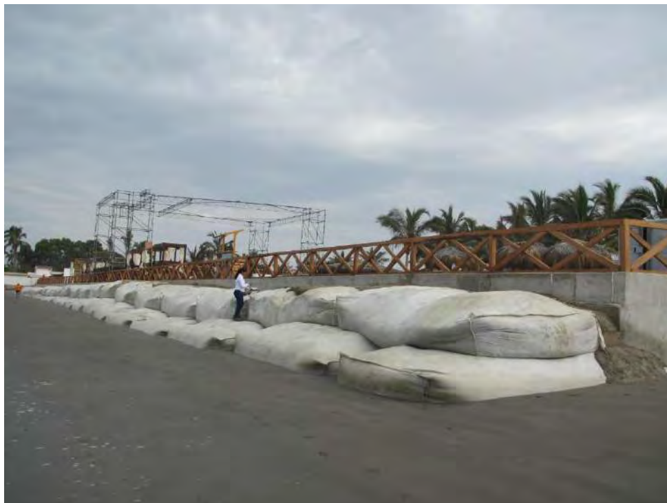
Fotografía C11. Vista longitudinal del revestimiento
