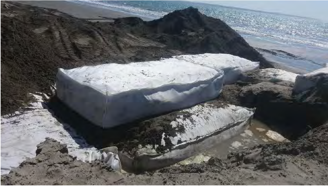
Fotografía C12. Geobolsas en esquina sur del local.
