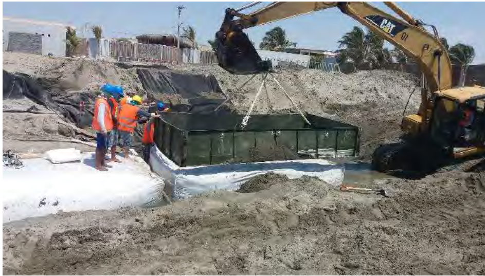
Fotografía C7. Desencofrado de geobolsa por izaje utilizando la cuchara de la excavadora
