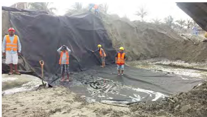
Figura 6. 6. Habilitación del geotextil no tejido
