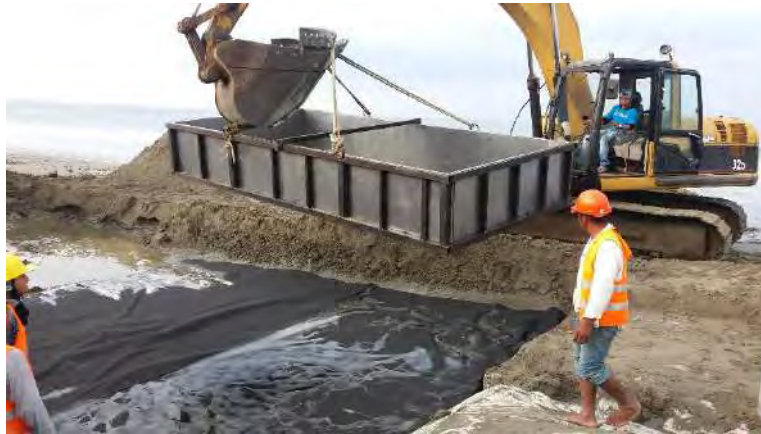
Figura 6. 18. Encofrado por medio de izaje del molde metálico
