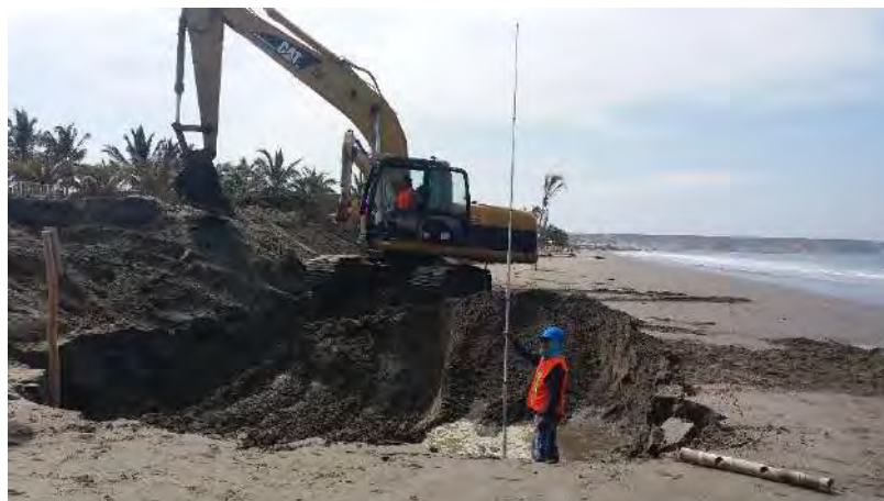
Figura 6. 4. Nivelación del terreno
