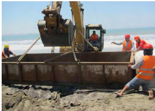
Figura 6. 7. Encofrado de geobolsas utilizando molde metálico
