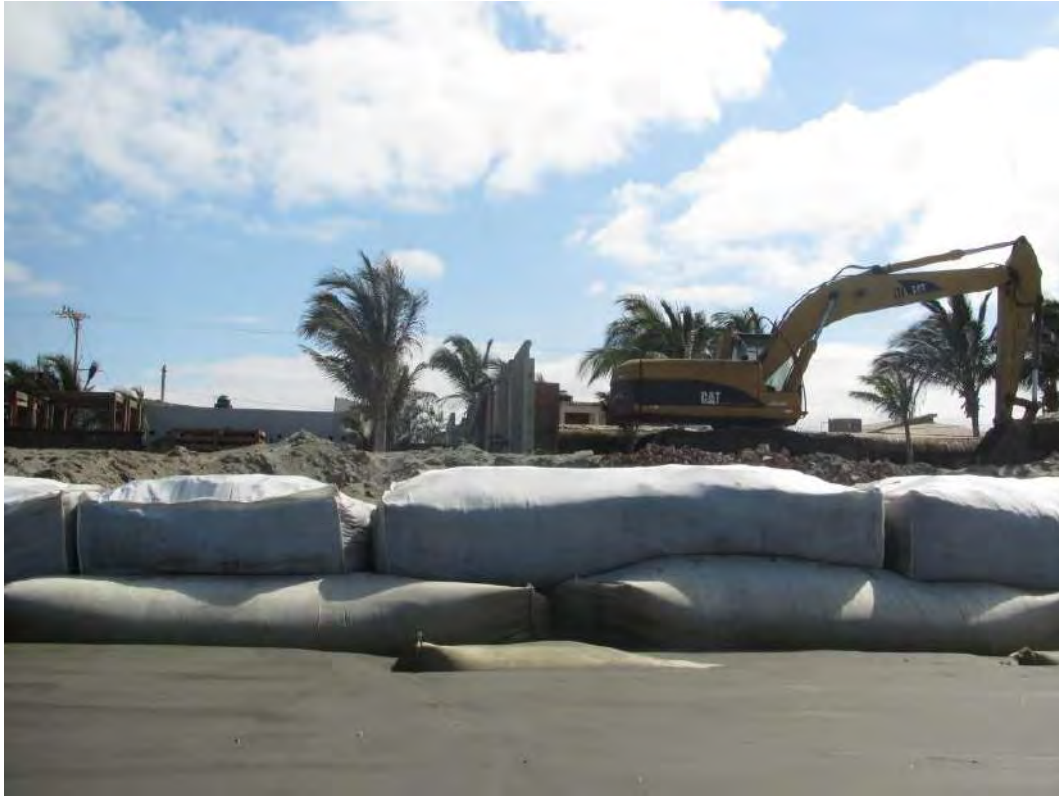
Fotografía C10. Vista frontal de estructura
