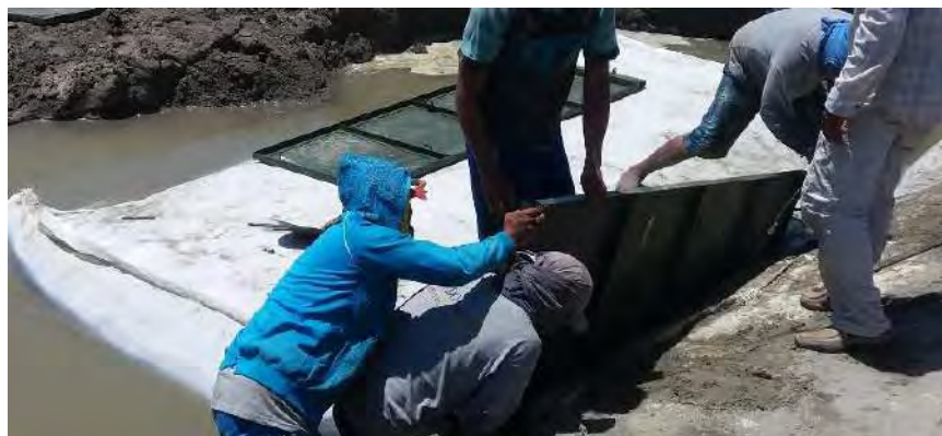
Figura 6. 17. Dificultades en el desencofrado de las planchas metálicas
