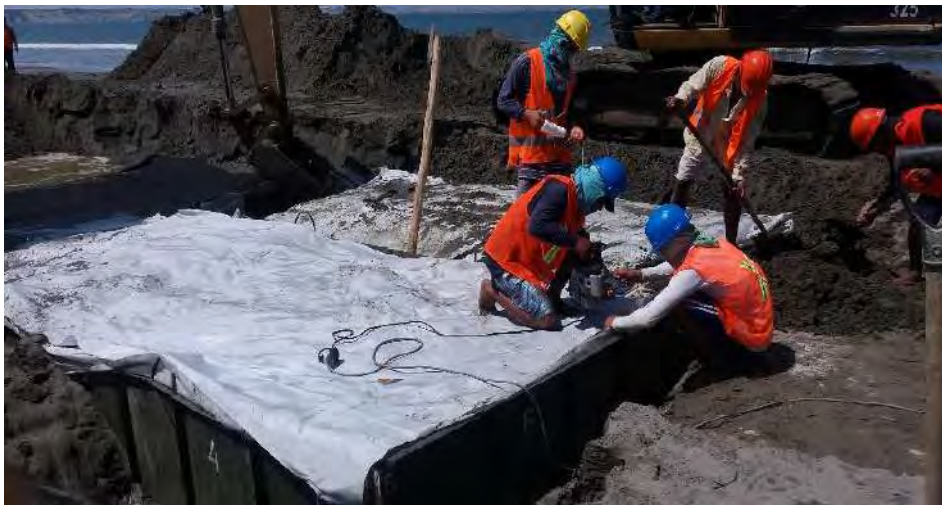
Fotografía C6. Cierre de geobolsas con cosedora manual especial
