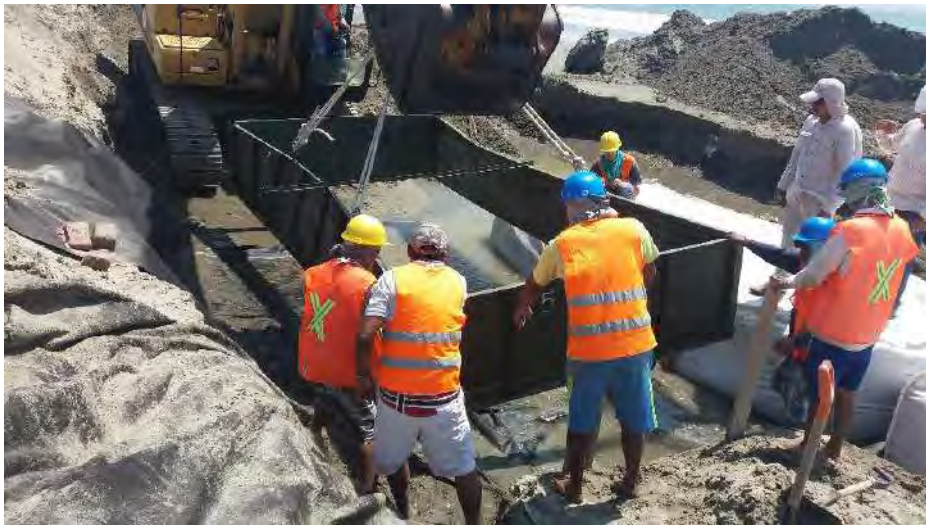
Fotografía C3. Colocación del molde metálico de encofrado mediante izaje con la excavadora
