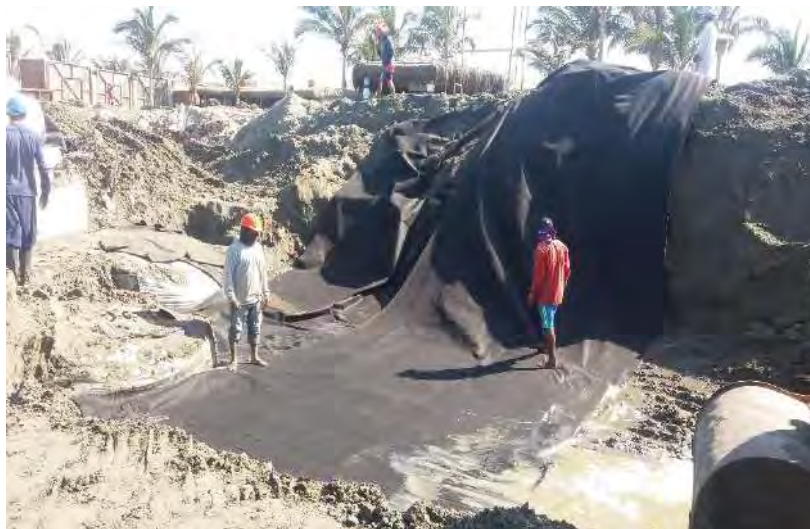
Fotografía C2. Extensión y colocación del geotextil no tejido sobre el terreno y el talud
