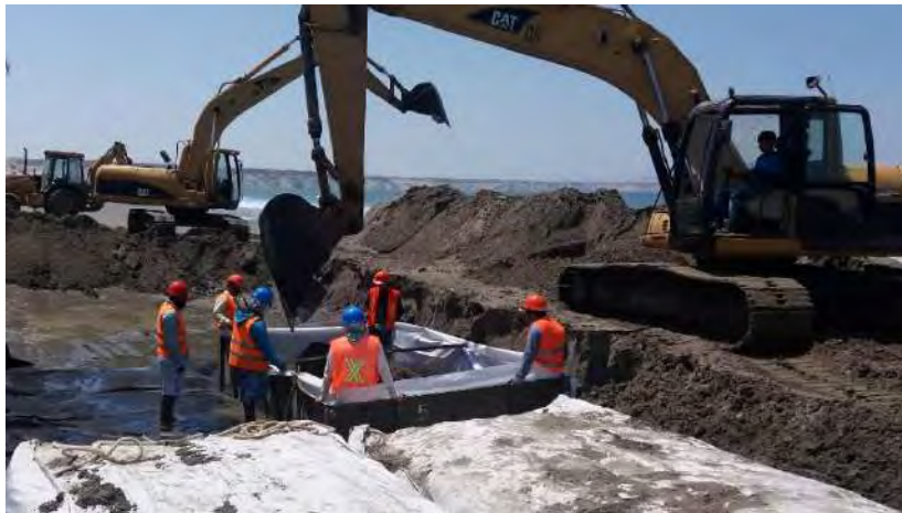
Figura 6. 9. Llenado de geobolsa con excavadora
