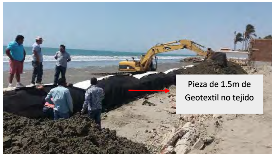
Figura 6. 16. Pieza de geotextil no tejido agregada
