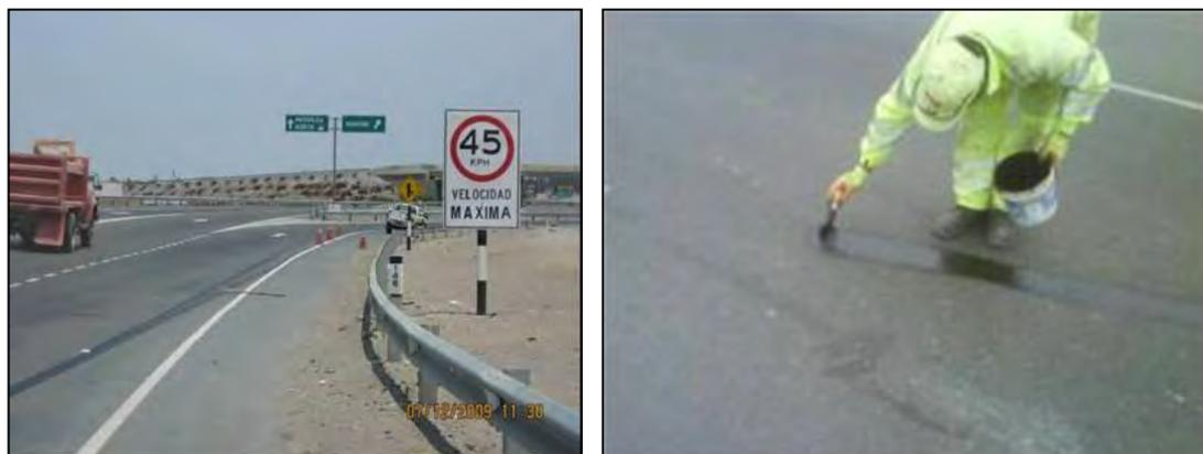
**Fig. 6.2. Trabajos de borrado de señales horizontales en los Km 147+400 y Km 203+650**
