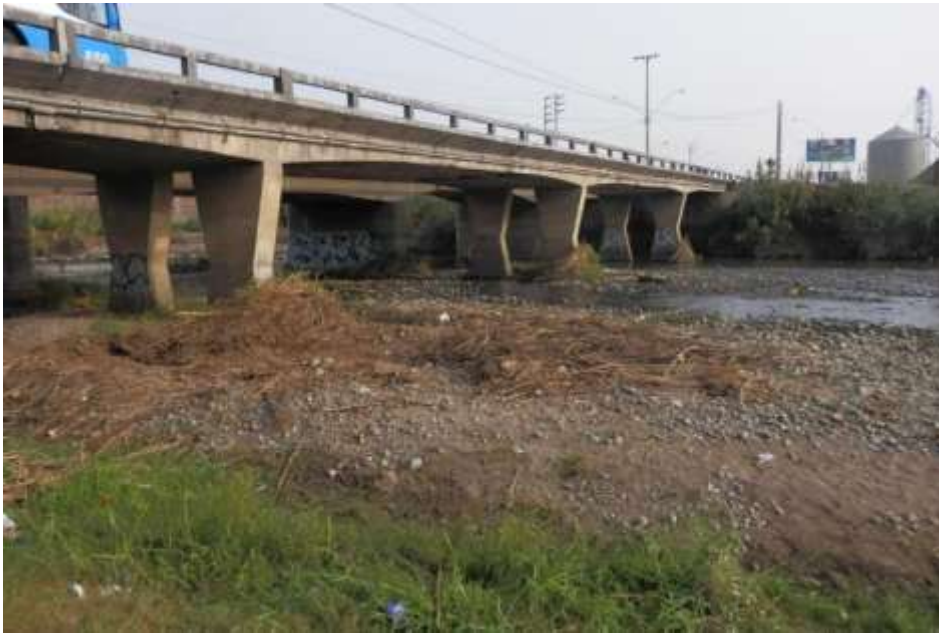
B1. Infraestructura del Puente Moche- Altura de la Carretera Panamericana Fuente: Elaboración propia
