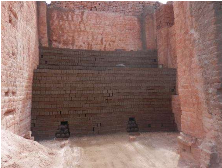
B50. Almacenamiento del adobe luego del proceso de obtención de ladrillos. Fuente: Elaboración propia
