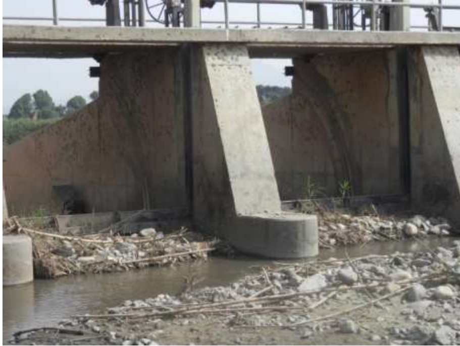
B5. Estado de la bocatoma Santa Lucía De Moche Fuente: Elaboración propia
