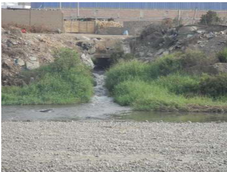
B39. Vertimiento de aguas residuales de la curtiembre La Ribera en la cuenca baja del río Moche
