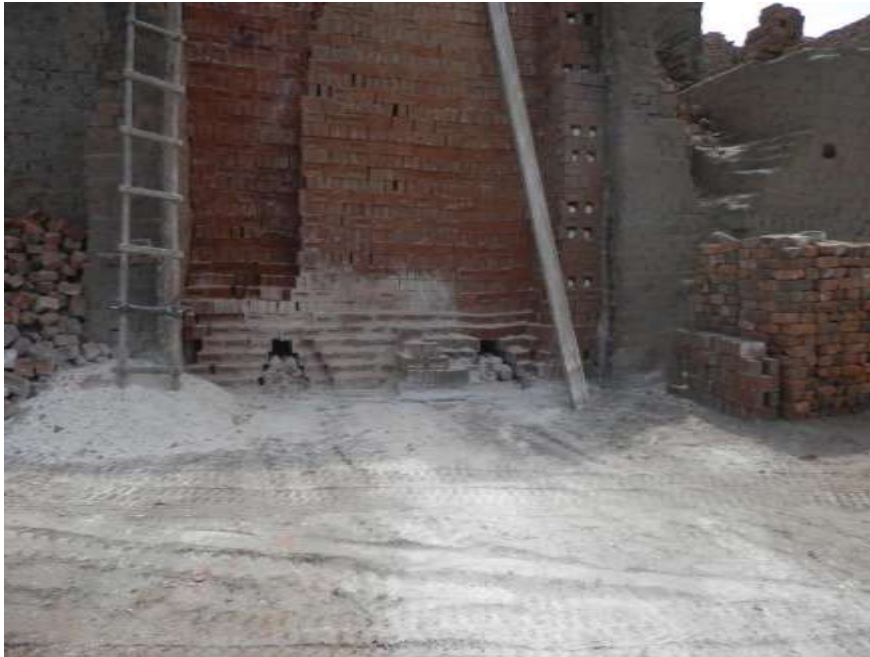
B49. Almacenamiento del adobe luego del proceso de obtención de ladrillos. Fuente: Elaboración propia
