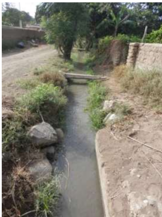
B12. Canal de derivación de tercer orden Fuente: Elaboración propia
