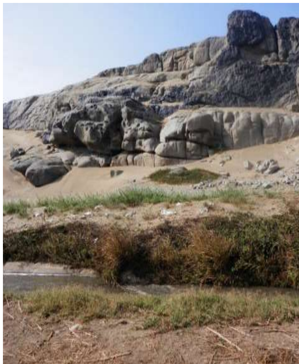
B10. Canal de derivación de segundo orden Fuente: Elaboración propia
