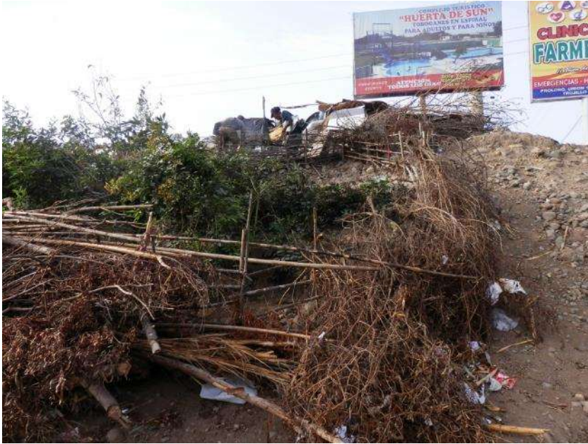
B33. Actividades antrópicas informales en las riberas del río Moche- Carretera Panamericana, a 5m. del Puente Moche. Fuente: Elaboración propia
