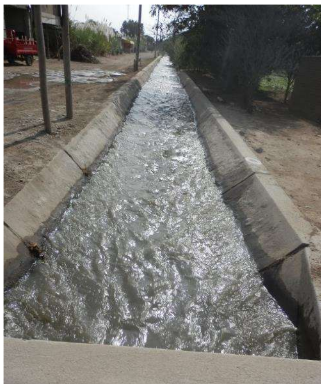
B8. Canal de derivación de primer orden Fuente: Elaboración propia
