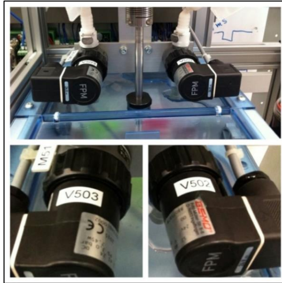
Figura 12 - Válvulas dosificadores V502 y V503
