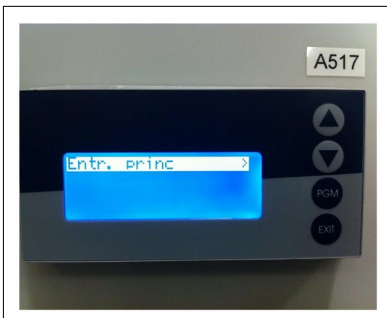
Figura 22 - Paso 4 - Entrada principal
