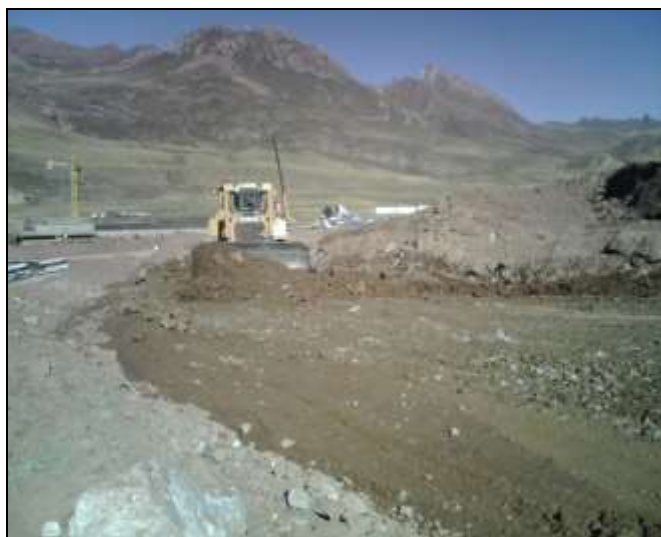
Fotografía 4.8 Esquema de corte realizado por un tractor
