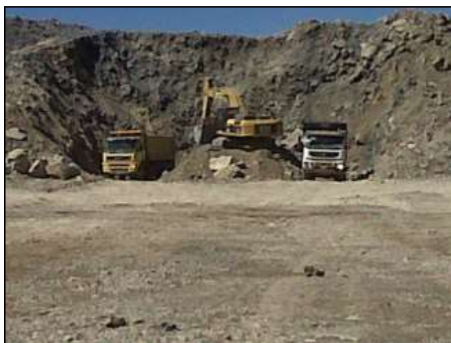
Fotografía 4.10 Carga de material en volquete
