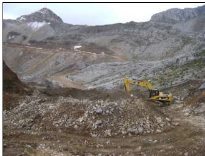
Fotografía 1.7 Excavación en material suelto.
