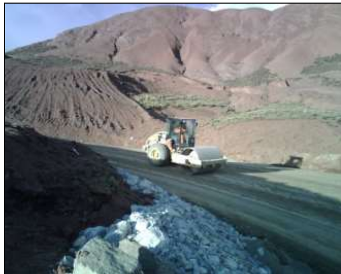
Fotografía 1.10 Rodillo vibratorio CS533E CAT
