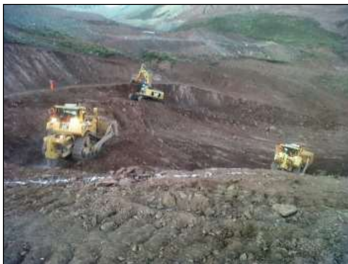
Fotografía 1.2 Excavación para la explanación
