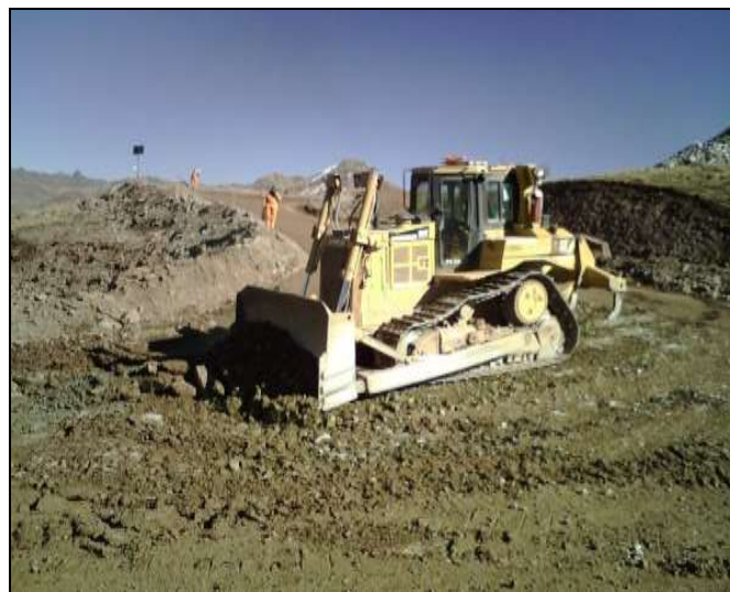
Fotografía 1.8 Extendido con el empleo de un tractor D7T
