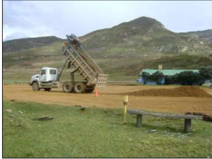
Fotografía 4.11 Colocación de material en área de relleno
