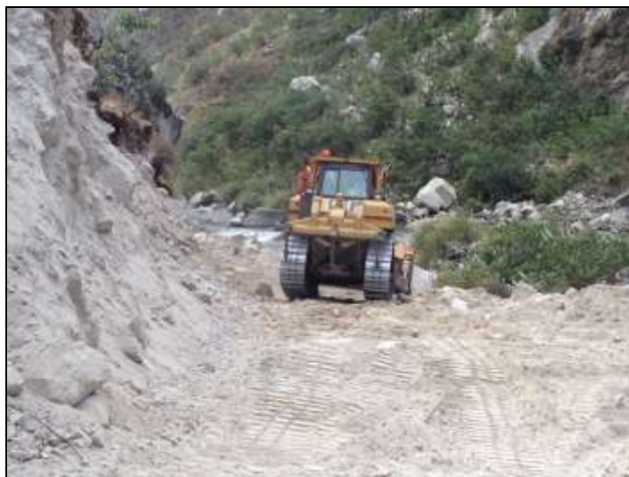
Fotografía 4.9 Corte de un talud realizado por un tractor
