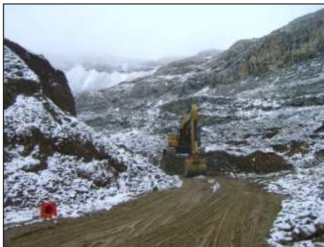
Fotografía 1.6 Excavación en roca suelta
