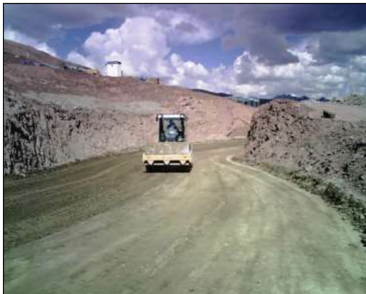
Fotografía 1.9 Compactación en la obra vial del proyecto minero
