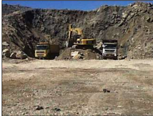
Fotografía 1.4 Excavación en la cantera Tunshuruco del proyecto
