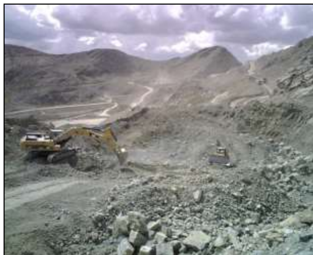
Fotografía 1.5 Excavación en roca fija en la cantera Tunshuruco
