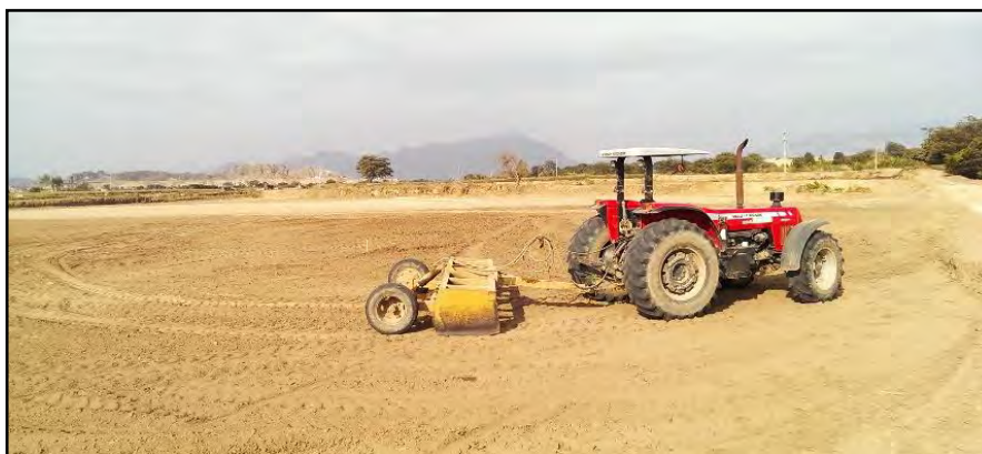
Figura 35. Trabajo de planchado y nivelación Parcela J-01, Jequetepeque. Fuente propia
