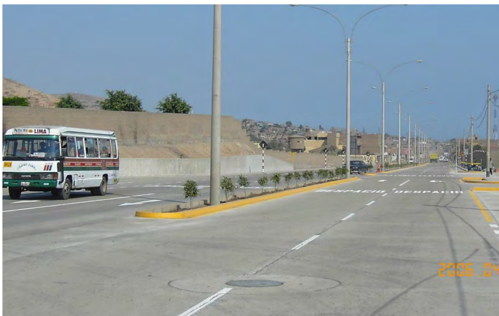
Figura 3.4: Pavimento de concreto simple con juntas
