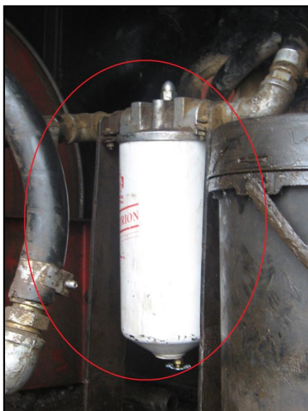
Foto. 3.4: Filtro surtidor del camión abastecedor XQ-8401, el petróleo filtrado se abastece a los tanques de los equipos. Se usa el filtro Nro-30036, filtra partículas de 30 \mu\text{m} que pueden ser partículas de agua y sólidos.
