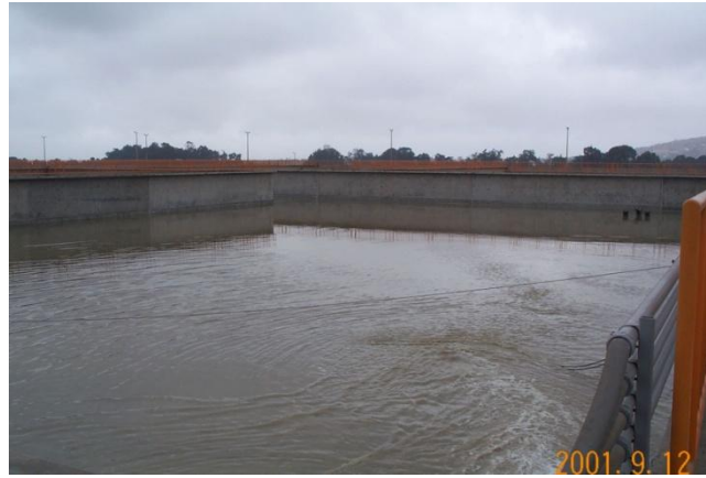
Figura 9.1: LAMP 1-1, 1-2, fase de llenado inicial (40 cm de nivel).
