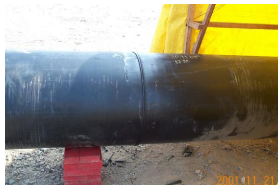
Figura 8.2: Termofusión de tubería de polietileno de alta densidad del Emisario submarino.
