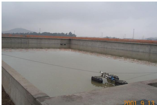
Figura 9.4: LAMP 1-3, fase de llenado inicial (40 cm de nivel).
