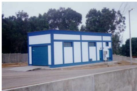
Figura 8.23: Edificio de cloración.
