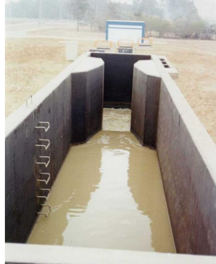
Figura 8.22: Medidor de caudal MC-2.
