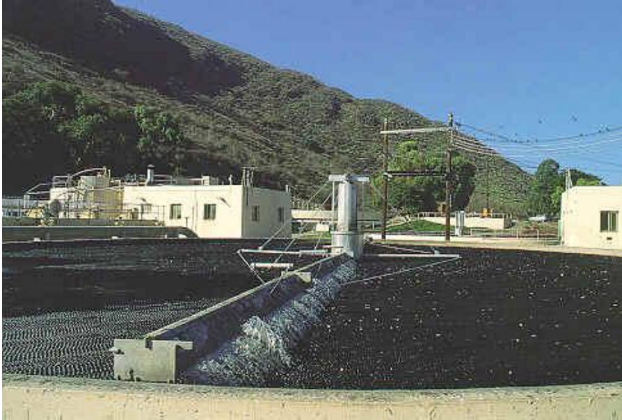
Figura 5.3: Filtro percolador de piedra (Tecate, México).
