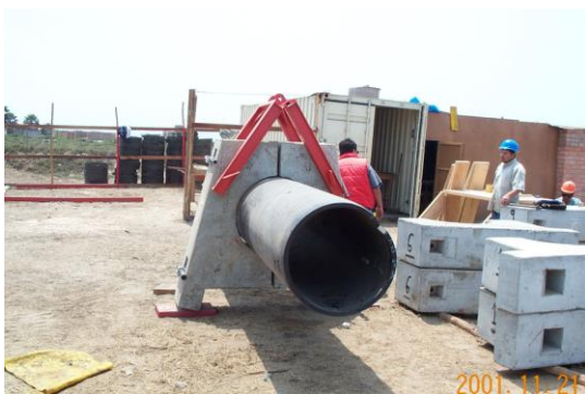
Figura 8.1: Anclajes para empotramiento de emisario submarino.
