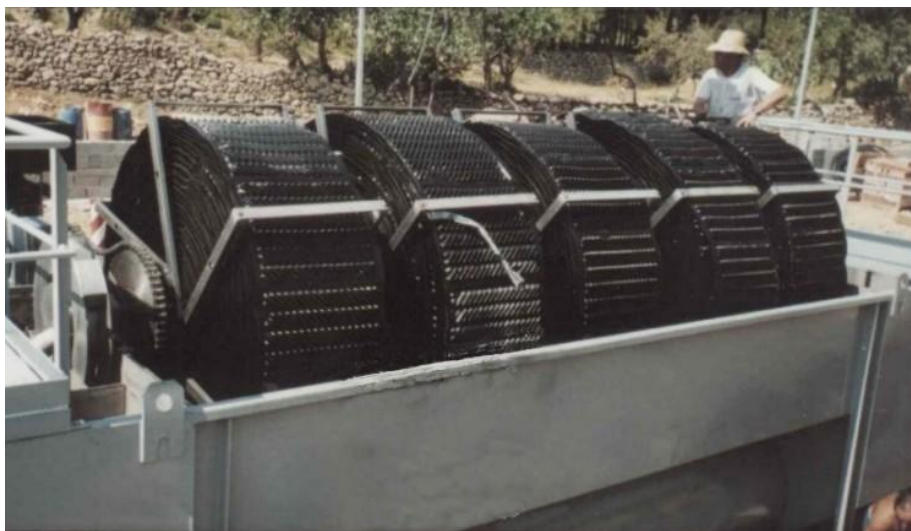
Figura 5.4: Discos biológicos rotatorios.
