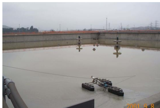
Figura 8.5: Foto del inicio de llenado de LAMC 1-2.
