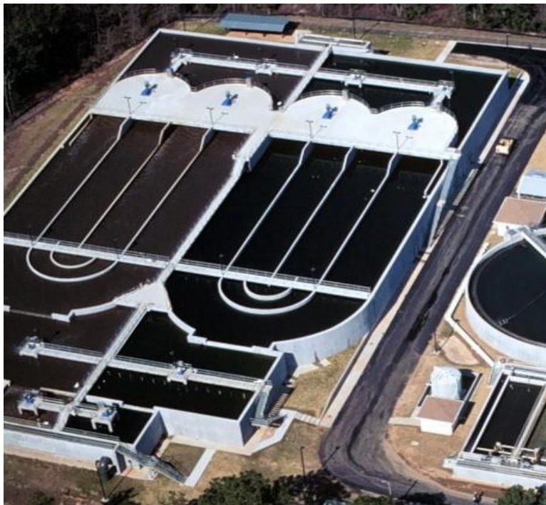
Figura 5.2: Vista de una PTAR modalidad zanjas de oxidación.
