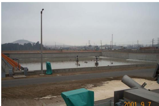
Figura 8.4: Foto del inicio de llenado de LAMC 1-1.
