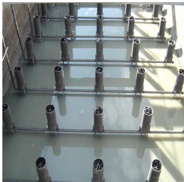
Figura 7.12: Foto de difusores de tubo estático.
