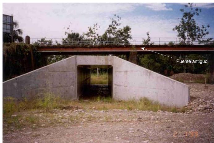
**Figura 1.11** Alcantarilla “de un ojo” en ejes 17 y 19.
