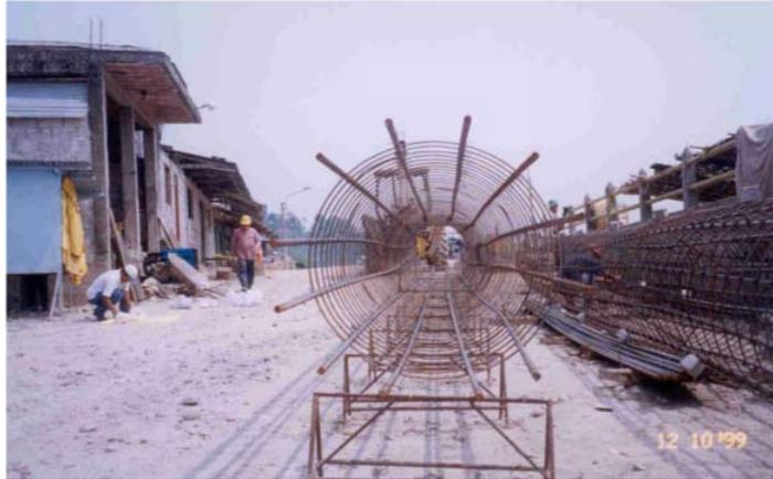
**Figura 3.12** Habilitación de armadura de refuerzo para columna de cimentación.
