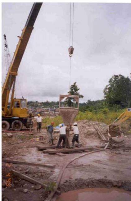
**Figura 3.14** Ducto metálico para colocación de concreto.
