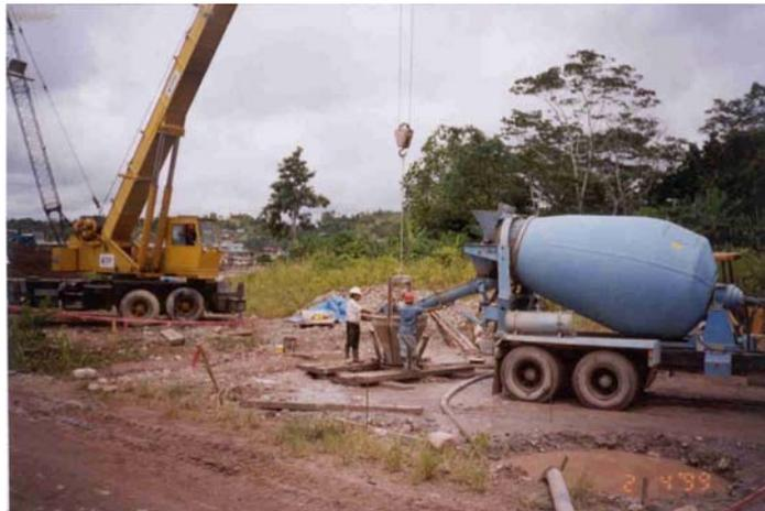
**Figura 3.15** Colocación de concreto en columnas de cimentación.
