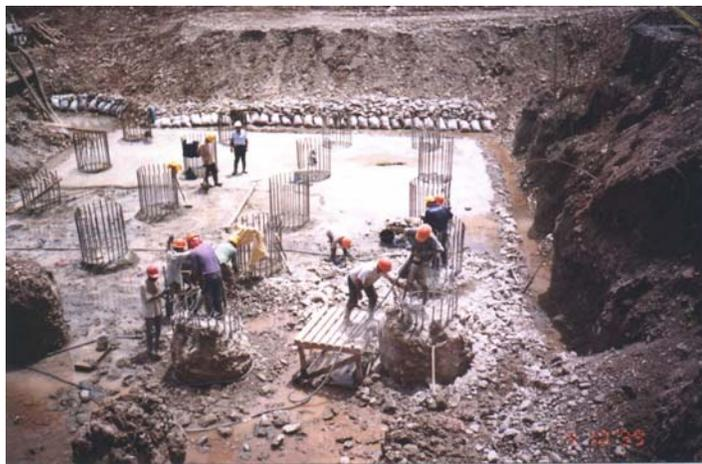
**Figura 3.16** Demolición de los cabezales de las columnas de cimentación.
