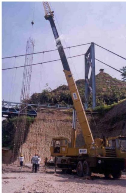
**Figura 3.13** Colocación de armadura de refuerzo.
