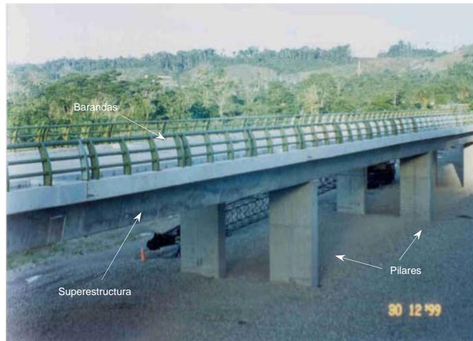
**Figura 1.4** Superestructura de concreto preesforzado apoyada sobre pilares.
