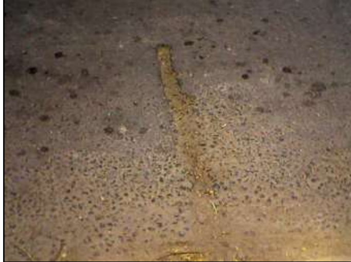
Figura 12. Fisura transversal.
