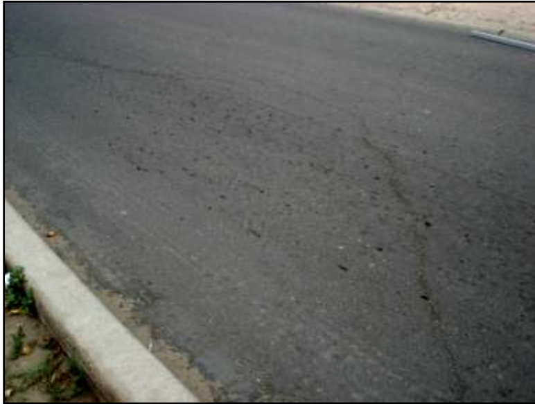
Figura 22. Fisura parabólica.
