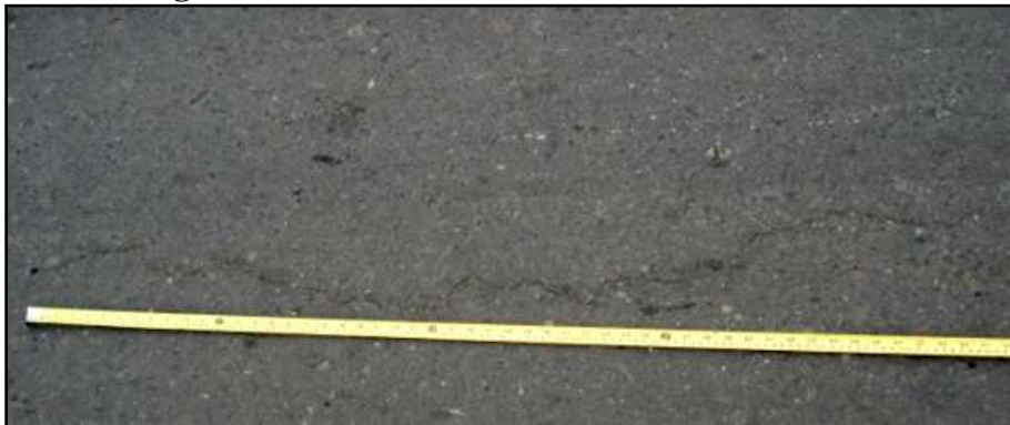
Figura 11. Fisura longitudinal.
