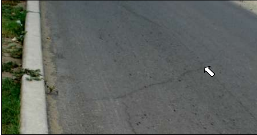
Figura 2.18. Fisura parabólica.
