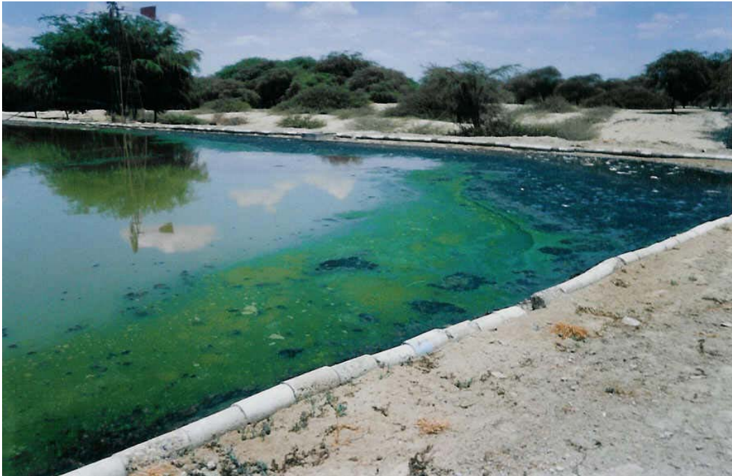
Foto A8. Presencia de natas en laguna primaria.
