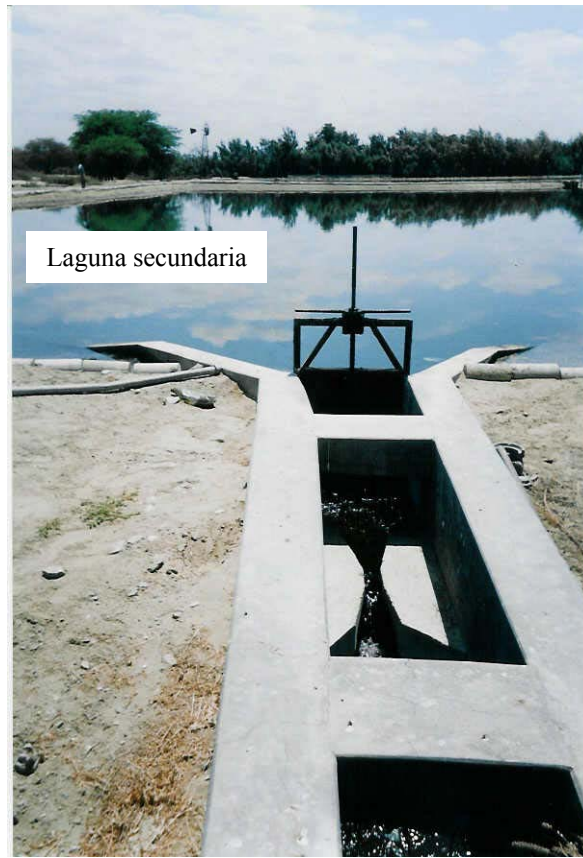
Foto A5. Estructura de salida.
