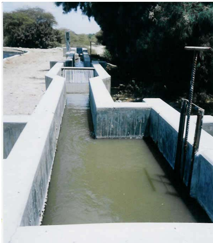
Foto A2. Estructura de entrada.
