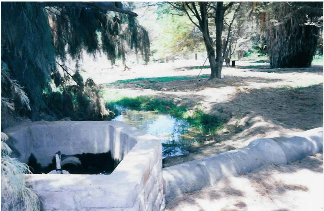
Foto A6. Tanque de distribución para riego a través de acequias y tuberías de concreto.
