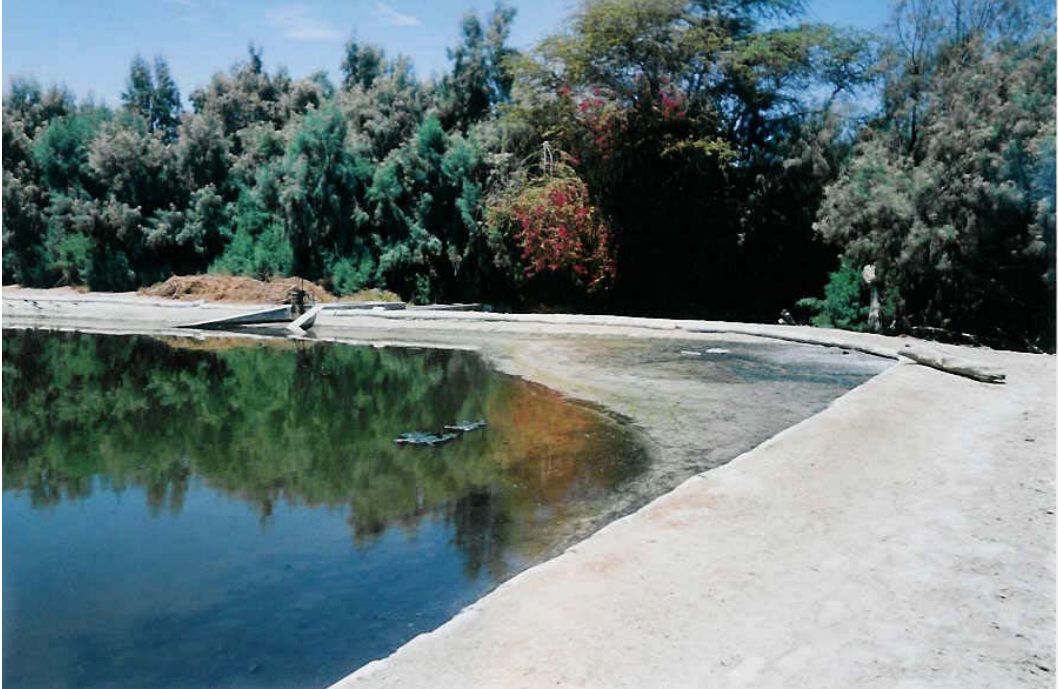
Foto A9. Presencia de natas en laguna secundaria.
