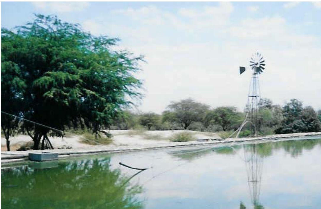
Foto A10. Sistema de incorporación de aire a laguna primaria en abandono.
